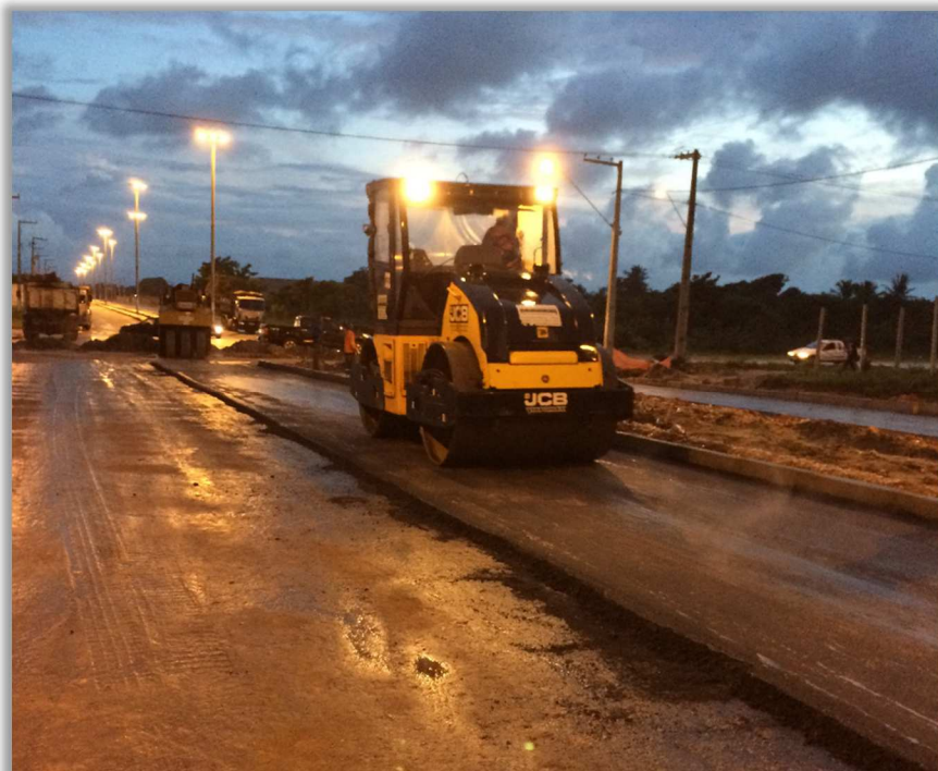
Figura 19 - Compactação com rolo de chapa.
