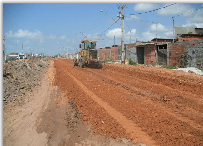
Figura 12 - Movimentação de Terra.
