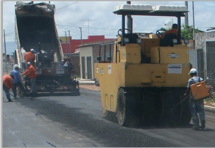
Figura 18 - Compactação com rolo de pneu.
