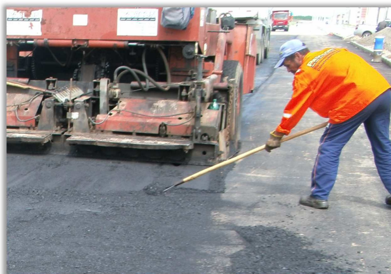
Figura 17 - Execução das Emendas.
