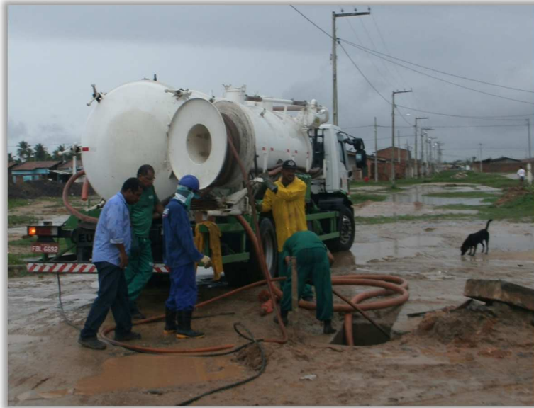
Figura 4 - Limpeza da rede de drenagem.
