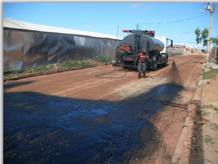
Figura 14 - Aplicação da Pintura Asfáltica.
