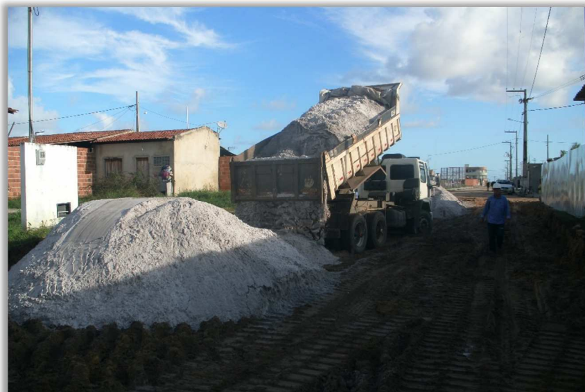
Figura 10 - Substituição do Solo
