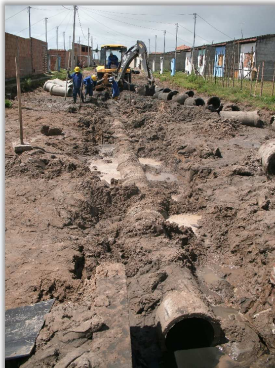
Figura 5 - Substituição da rede de drenagem.
