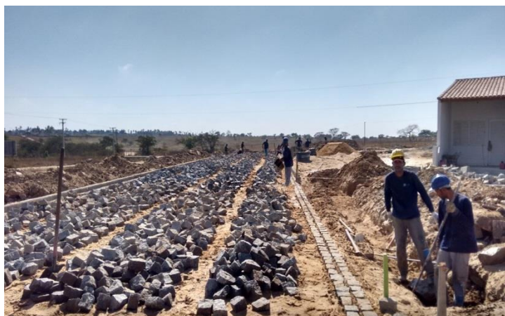
Figura 6: Acompanhamento da execução de paralelepípedo.
