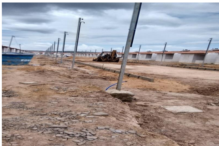
Figura5: Acompanhamento da execução da sub-base e base.
