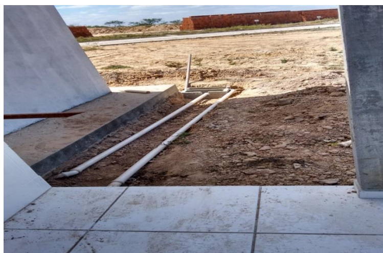
Figura: 1 Assentamento das caixas de inspeção para recebimento do esgoto doméstico.
