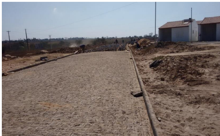
Figura 8: Acompanhamento da execução de paralelepípedo.
