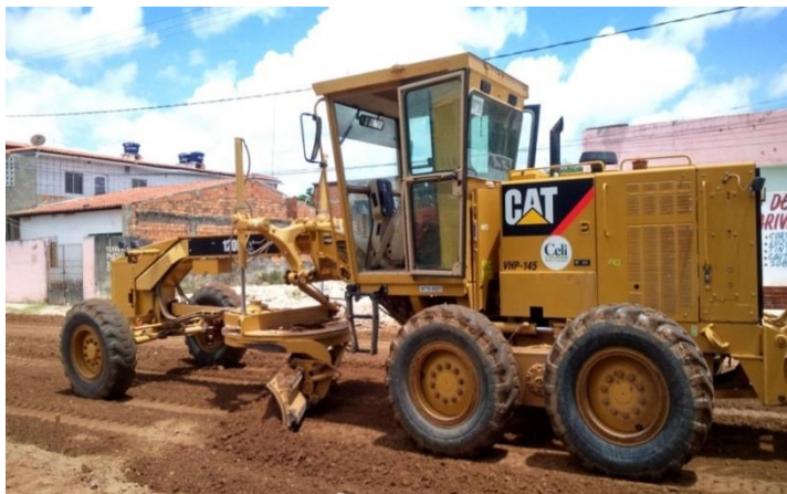
Figura 4: Acompanhamento da execução da sub-base e base.
