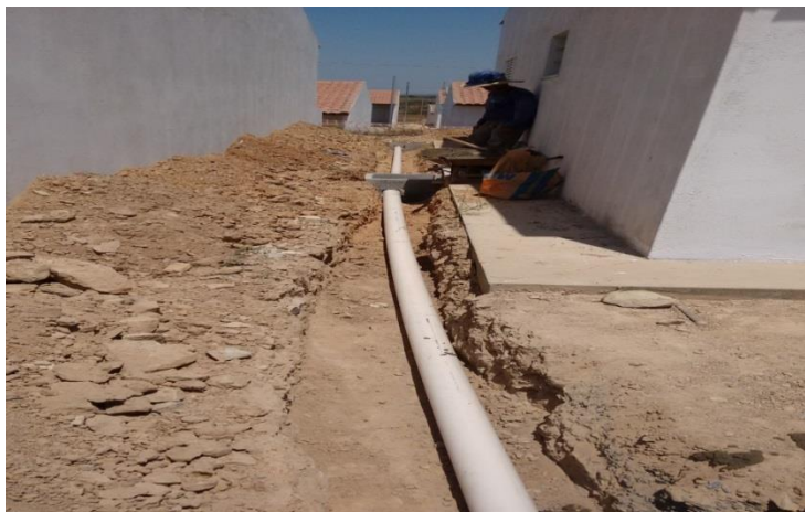
Figura 2 - Assentamento das caixas de inspeção Para recebimento do esgoto doméstico
