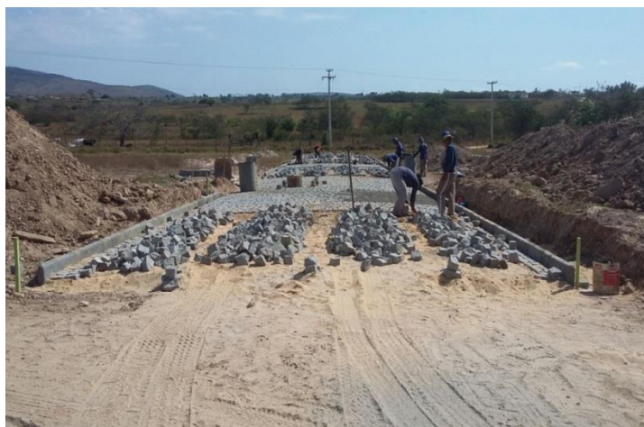
Figura 7: Acompanhamento da execução de paralelepípedo.
