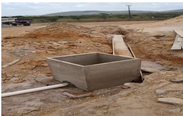
Figura 3 - Assentamento de rede de captação para recebimento das águas pluviais
