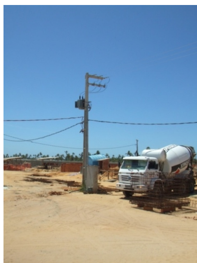
Figura 11 – Canteiro de obra com poste já colocado
