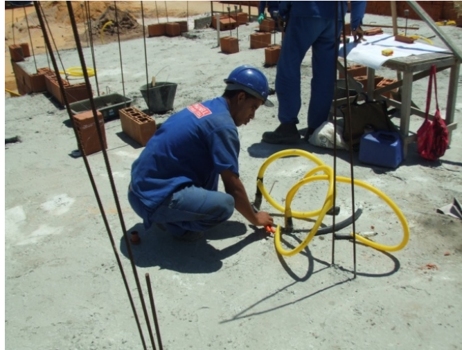
Figura 5 – Acompanhamento de alvenaria
