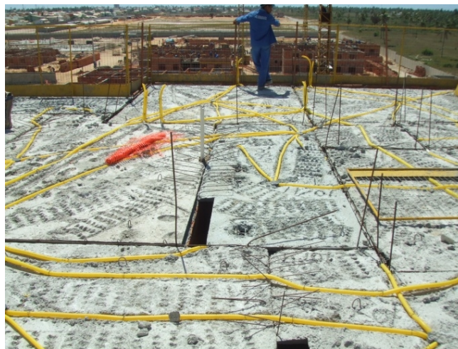
Figura 4- Tubulação da Laje já inclusa
