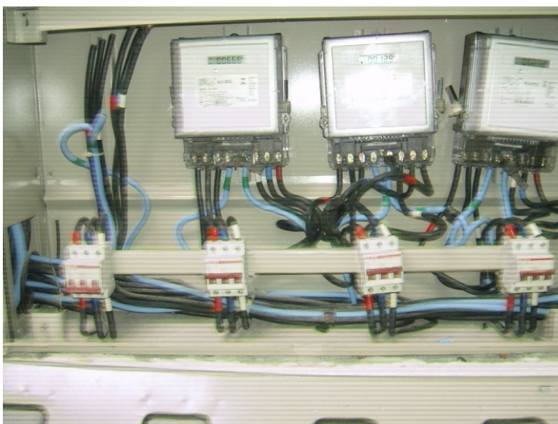
Figura 9 – Centro de medição
