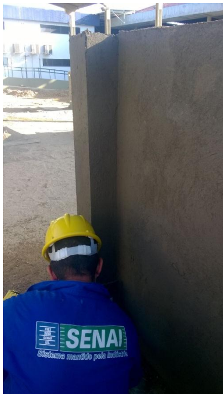
Foto 9: Revestimento em argamassa de parede/ Reboco
