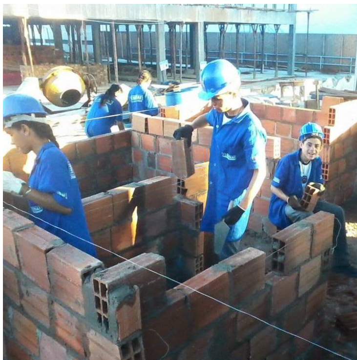
Foto 7: Assentamento das bloco cerâmico
