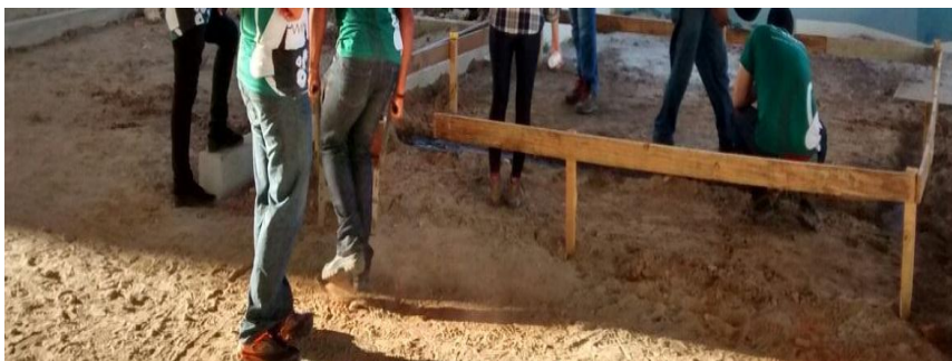
Foto 1: Montagem do gabarito
