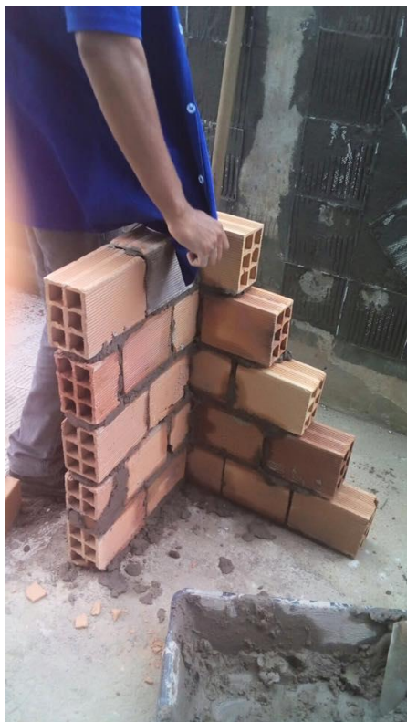
Foto 4: Assentamento das bloco cerâmico
