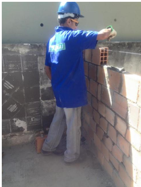
Foto 5: Assentamento das bloco cerâmico/Verificação do alinhamento
