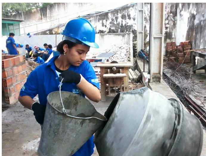
Foto 3: Utilização da betoneira no preparo de argamassa e concreto
