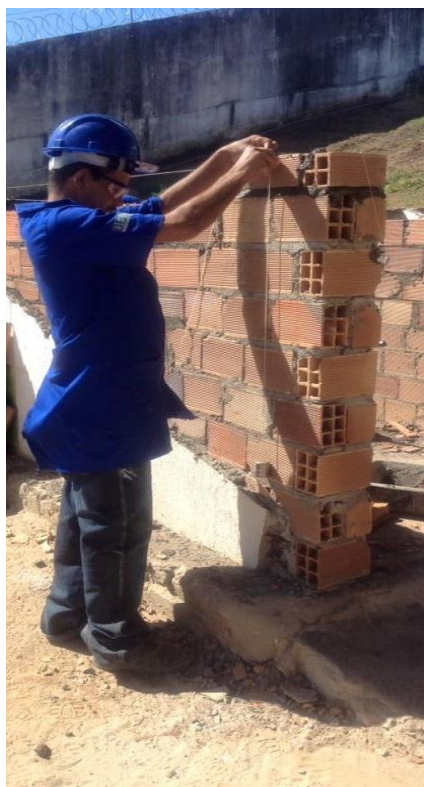
Foto 6: Assentamento das bloco cerâmico / Verificação do prumo
