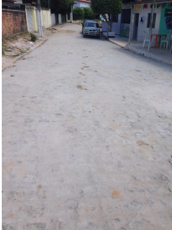
Figura 3: Remoção do paralelepípedo de diversas ruas do bairro Roque Mendes
