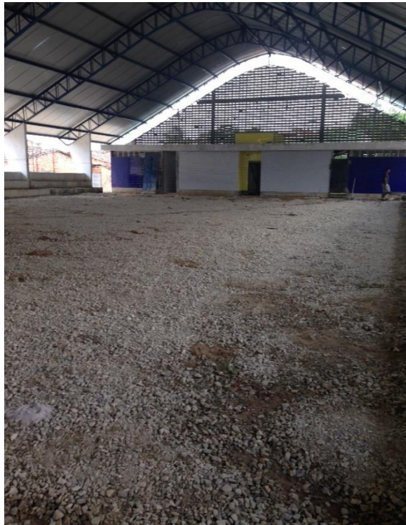
Figura 5: Cobertura com telha metálica da Construção da quadra coberta com vestiário na escola Conego Antônio de Barros Padilha
