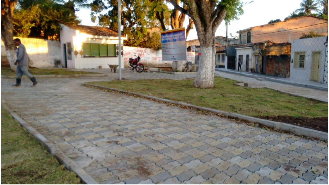
Figura 7: Piso intertravado da reforma e urbanização da praça Francisco Rabelo Leite
