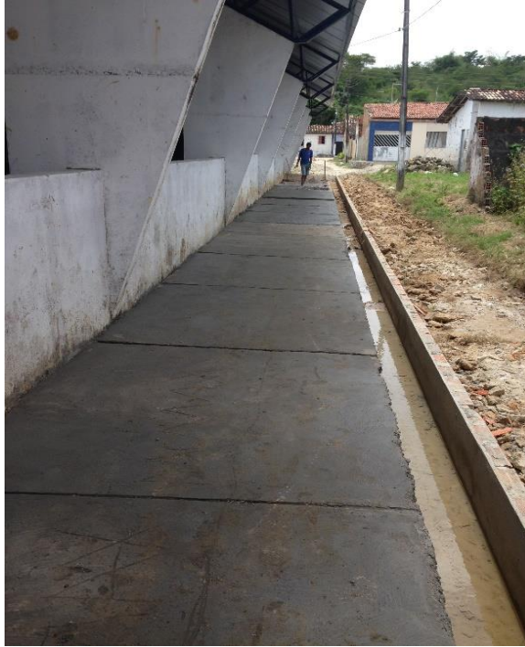
Figura 4: Construção da quadra coberta com vestiário na escola Conego Antônio de Barros Padilha
