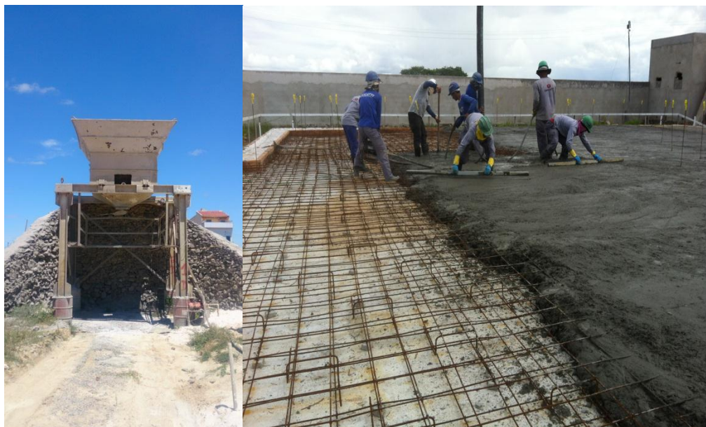
Figura 3.8: mini usina de concretagem; lançamento e sarrafeamento. Fonte: Autor
