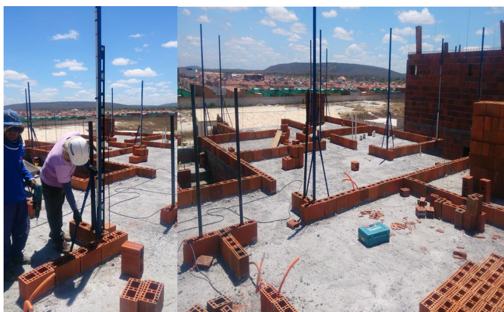
Figura 3.1: primeira fiada e instalação dos escantilhão. Fonte: Autor.
