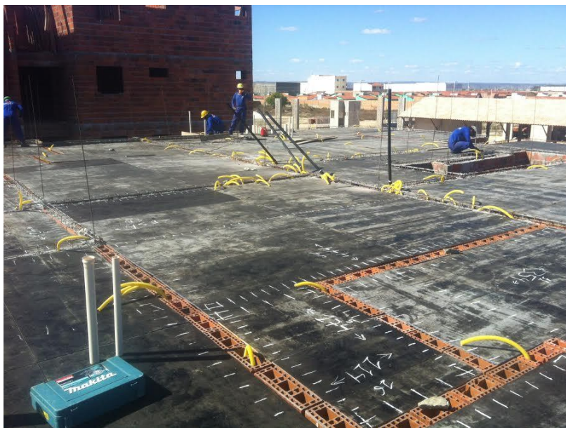
Figura 3.4: detalhe da instalação das formas de laje. Fonte: Autor
