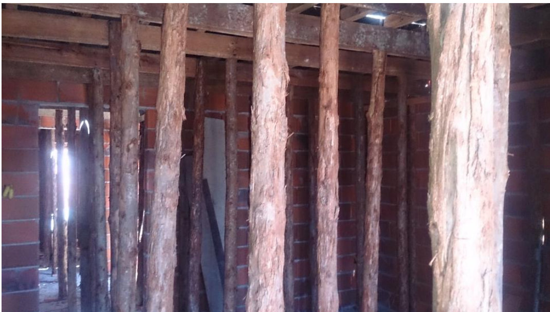
Figura 3.5: detalhe do escoramento com escoras de eucalipto. Fonte: Autor
