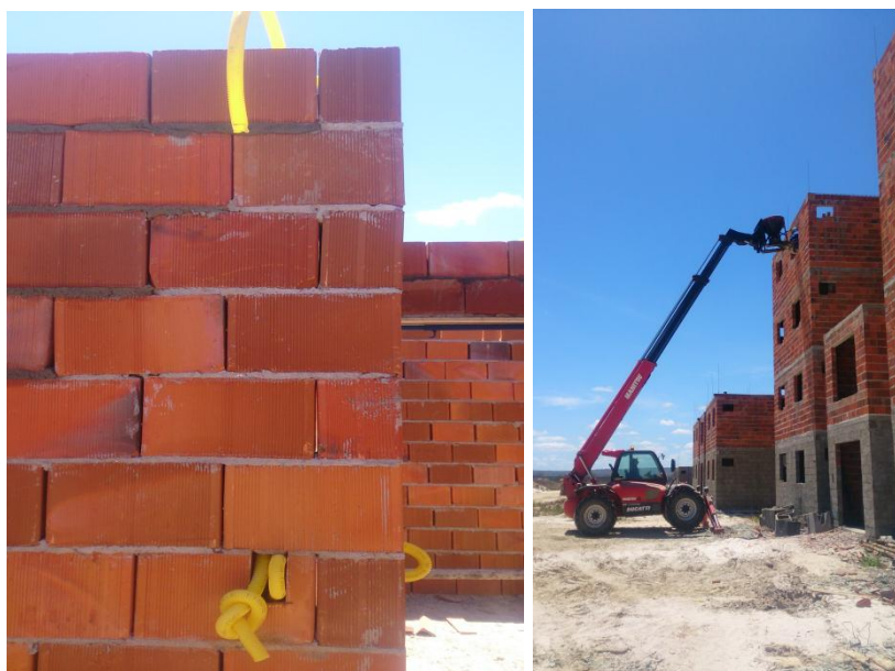
Figura 3.3: detalhe da instalação dos eletrodutos e elevação de material via manipuladora. Fonte: Autor.
