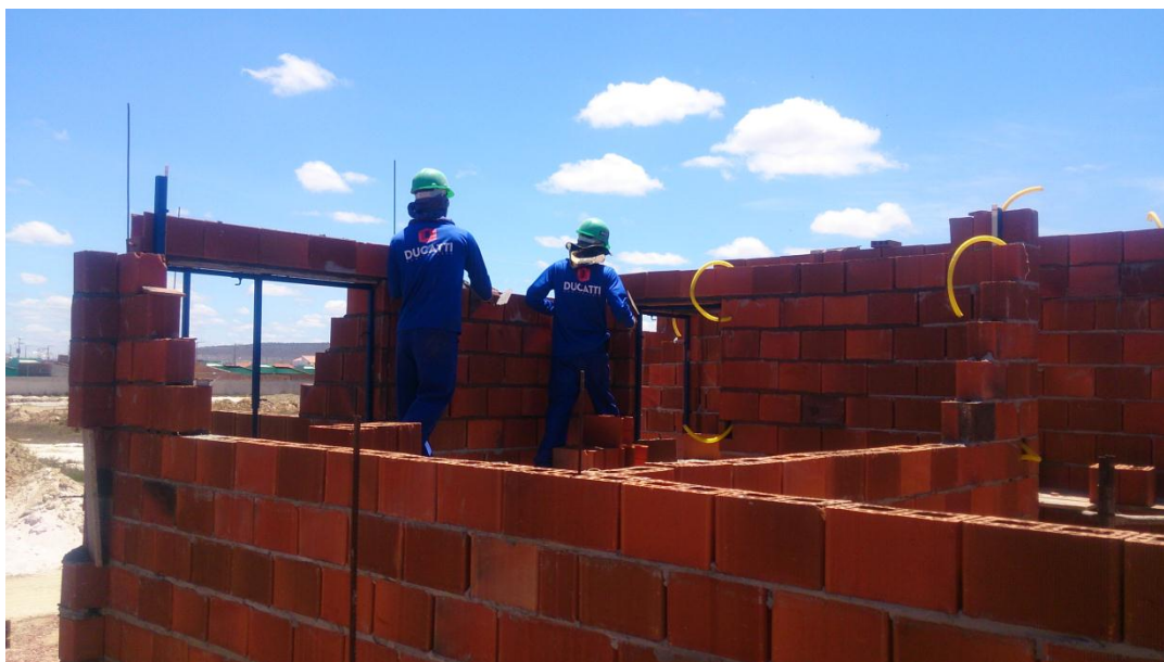
Figura 3.2: levante de alvenaria com auxílio de gabarito de janelas. Fonte: Autor.
