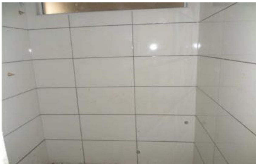
Figura 08: Revestimento cerâmico Acabado
