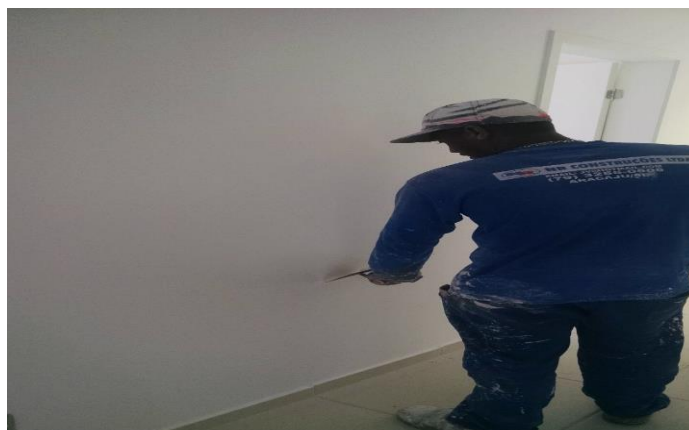
Figura 09: Processo de Emassamento da parede
