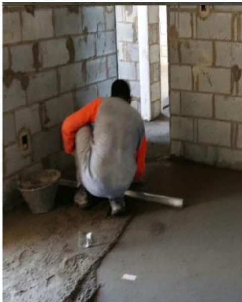
Figura 02: processo de sarrafeamento
