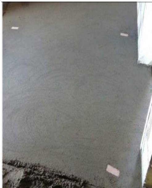
Figura 03: Contra piso Acabado
