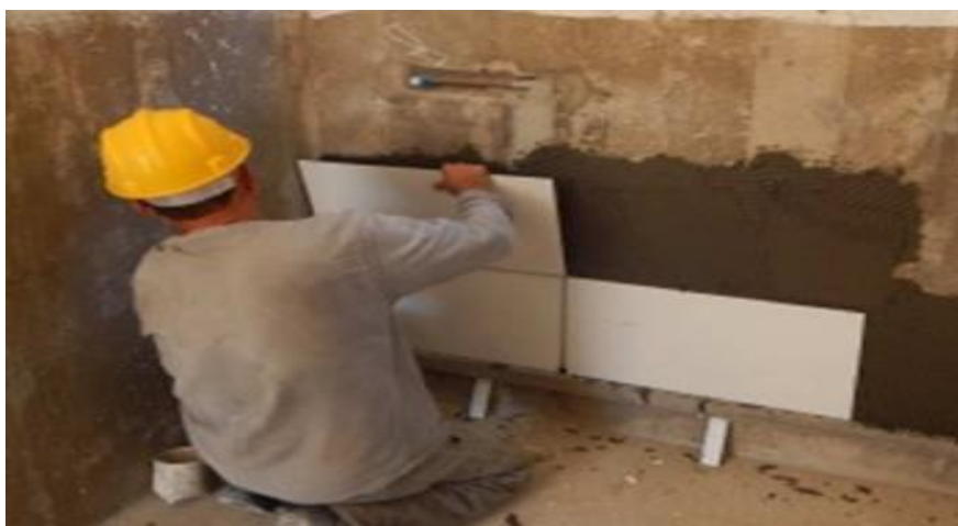
Figura 07: assentamento do Revestimento Cerâmico
