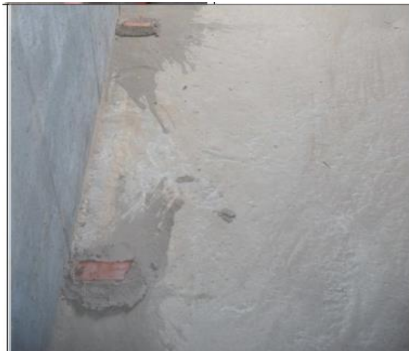
Figura01: Processo de emestramento para o contrapiso
