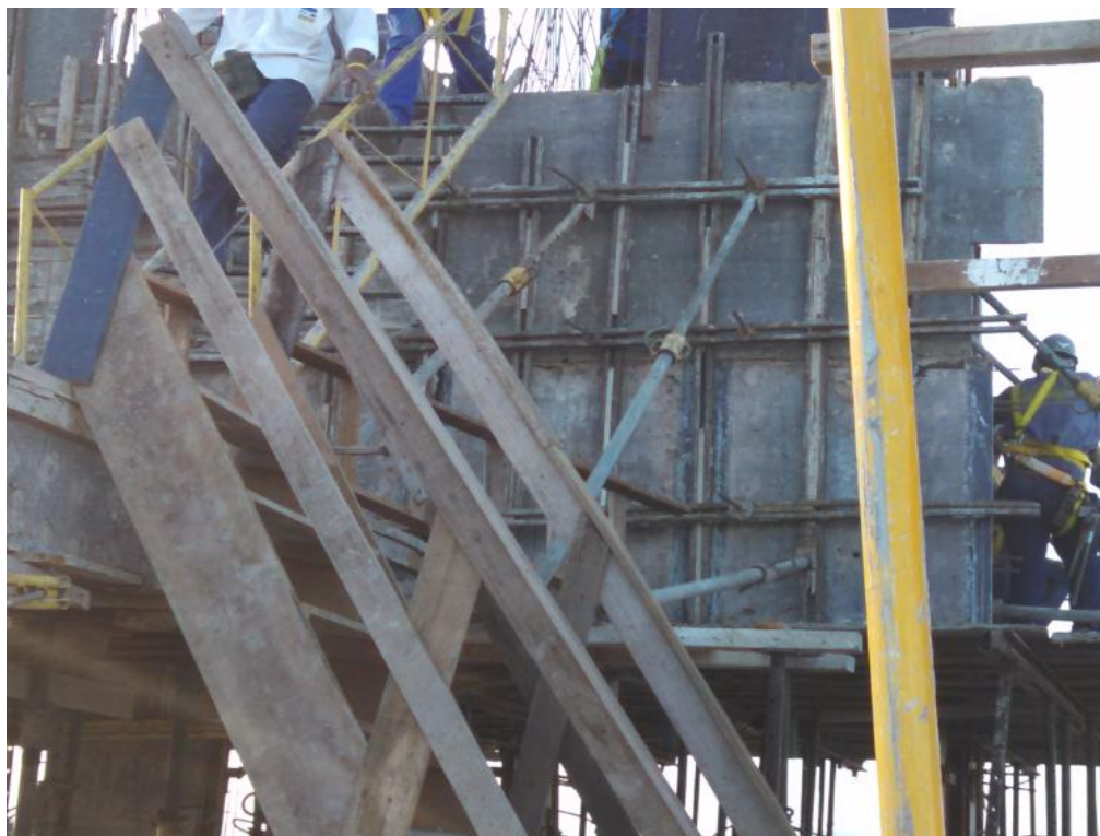
Figura 5: Formas e escoramentos posicionados
