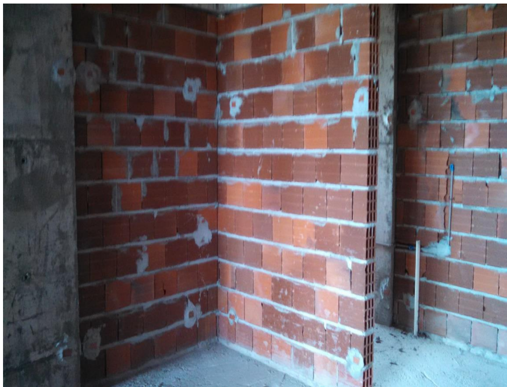
Figura 12: Assentamento de taliscas.
