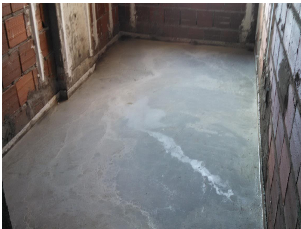
Figura 13: Mestras para Gesso e Reboco.
