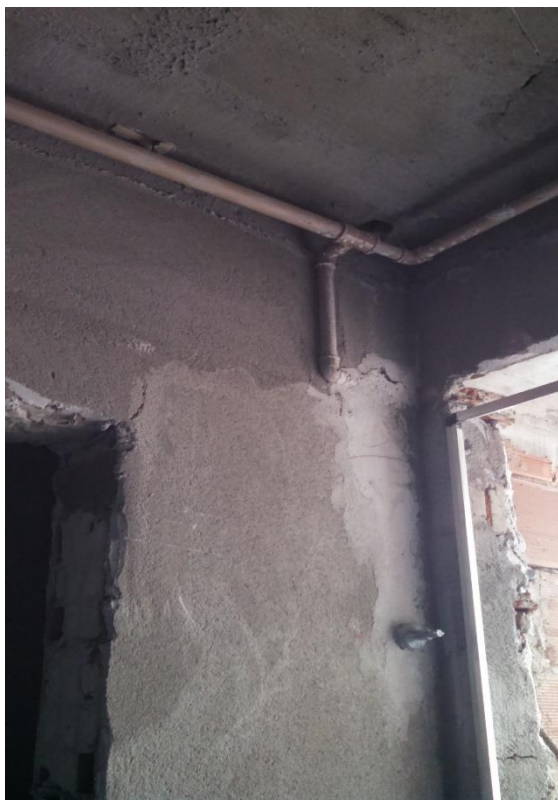
Figura 15: Vista Emboço executado.
