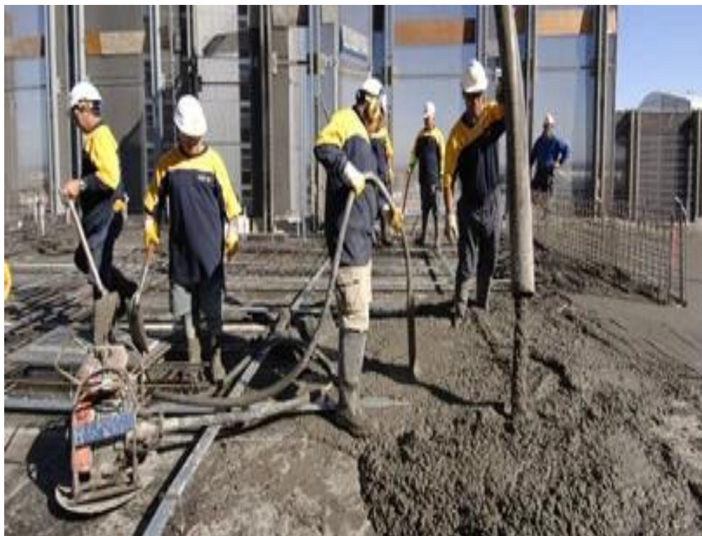
Figura 8: Lançamento e vibração de concreto.
