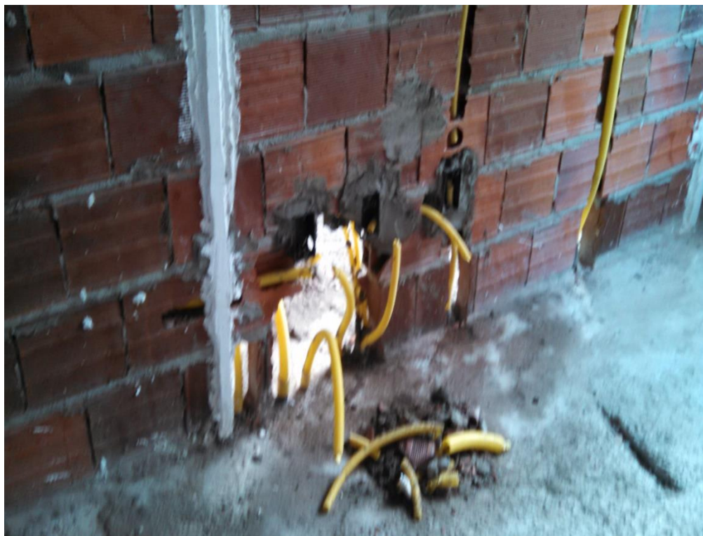
Figura 11: Passagens de tubulação elétrica e chumbamento de caixinhas.
