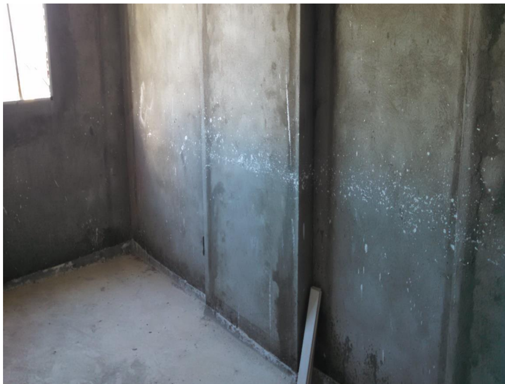
Figura 14: Vista Reboco executado.
