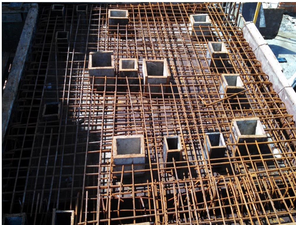
Figura 6: Ferragens em fase de posicionamento.
