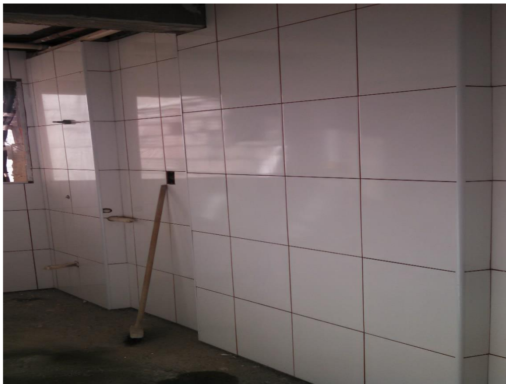
Figura 17: Assentamento de cerâmica.
