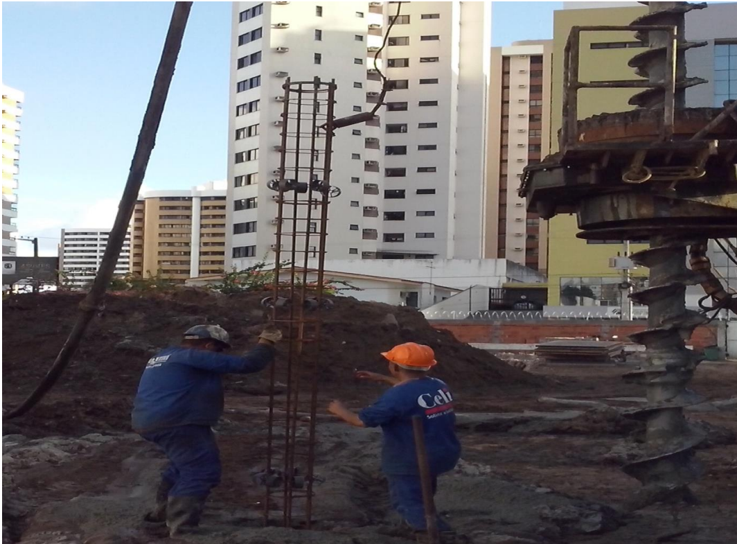
Figura 4 – Colocação da ferragem na estaca concretada.
