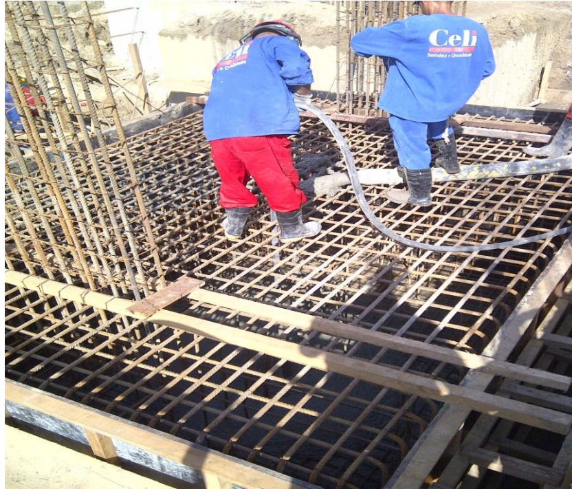
Figura 9 – Concretagem com concreto usinado
