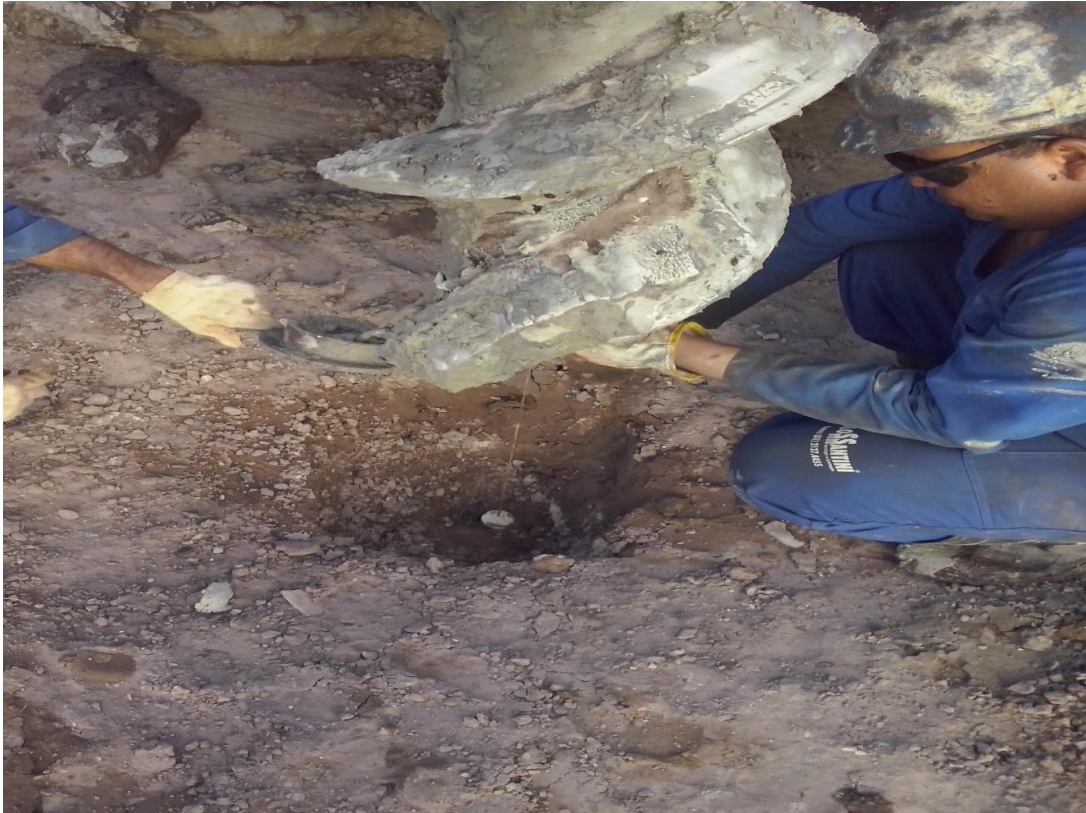
Figura 3 – Locação do trado no ponto marcado
