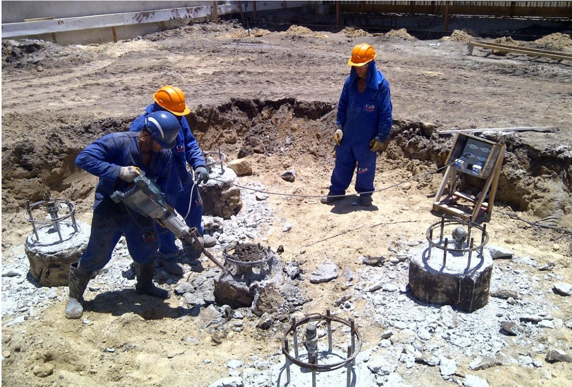
Figura 5 – Arrasamento de Estacas
