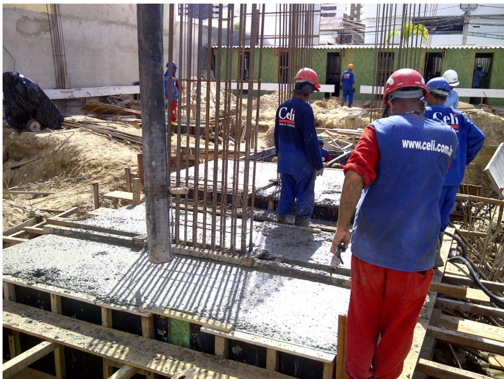
Figura 10 – Inspeção visual após concretagem
