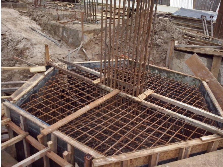
Figura 8 – Montagem de armadura para concreto armado na forma
