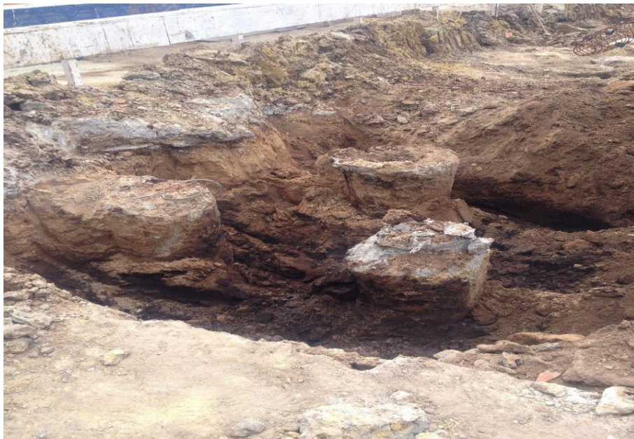
Figura 08: Abertura das estacas
