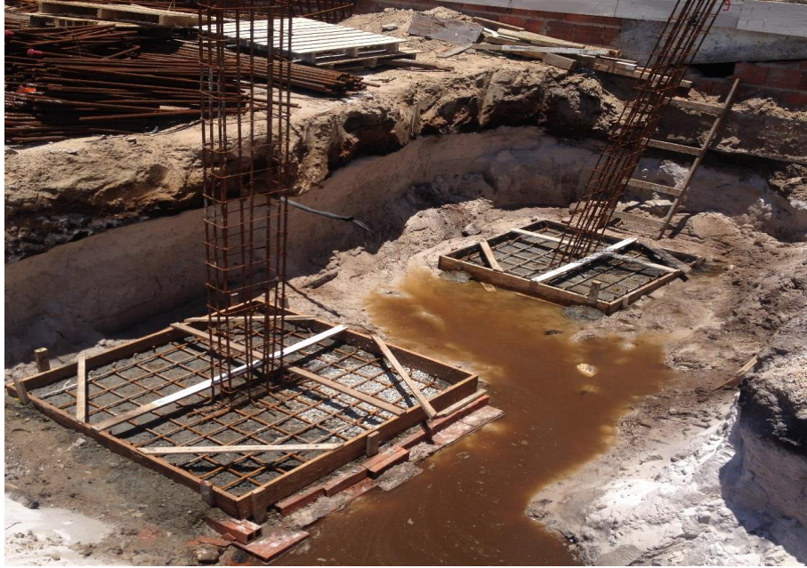
Figura 11: Armação de sapatas e pilares
