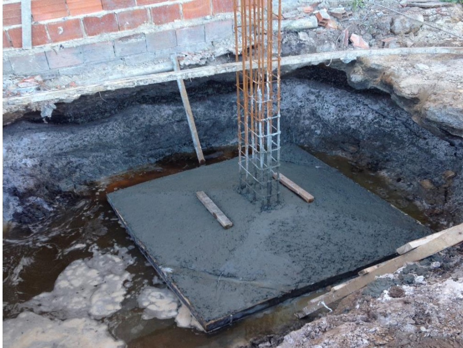
Figura 13: Concretagem de sapata
