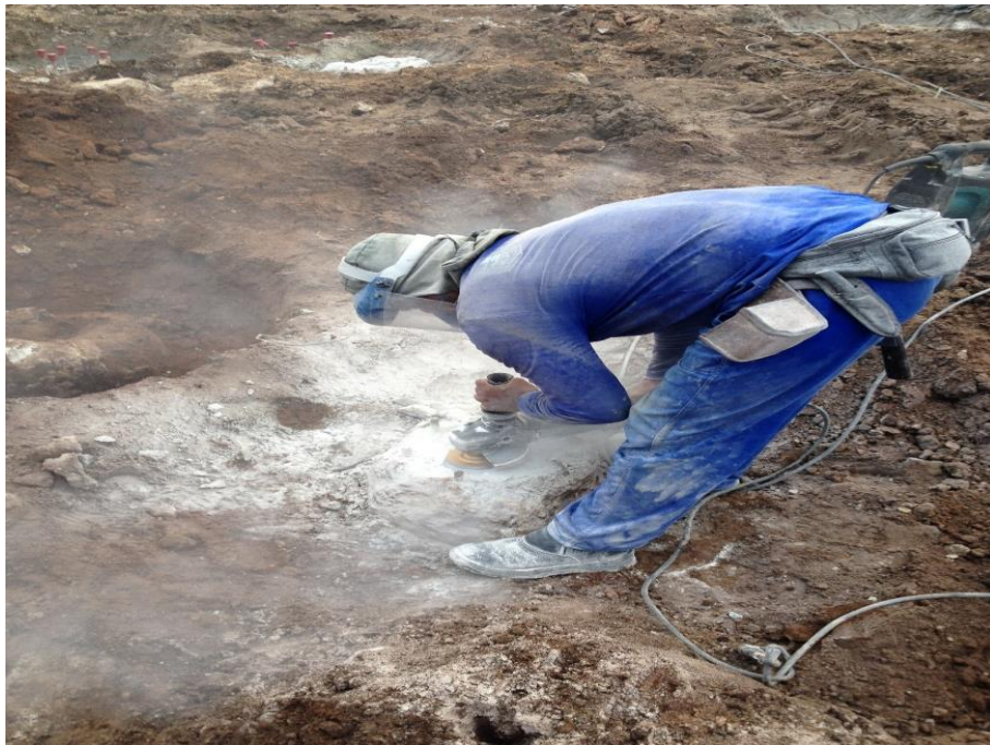
Figura 18: Rebolo de estaca para teste de PIT
