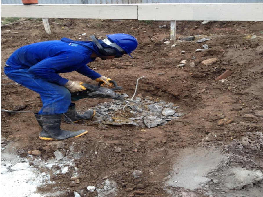
Figura 17: Arrasamento de estaca para teste de PIT
