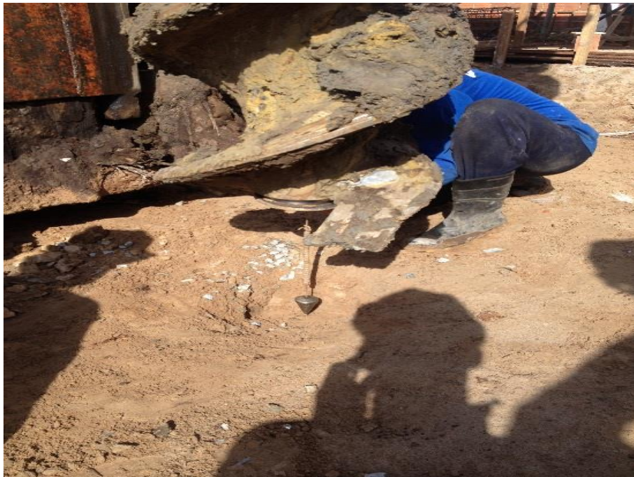
Figura 05: Marcação para perfuração das estacas
