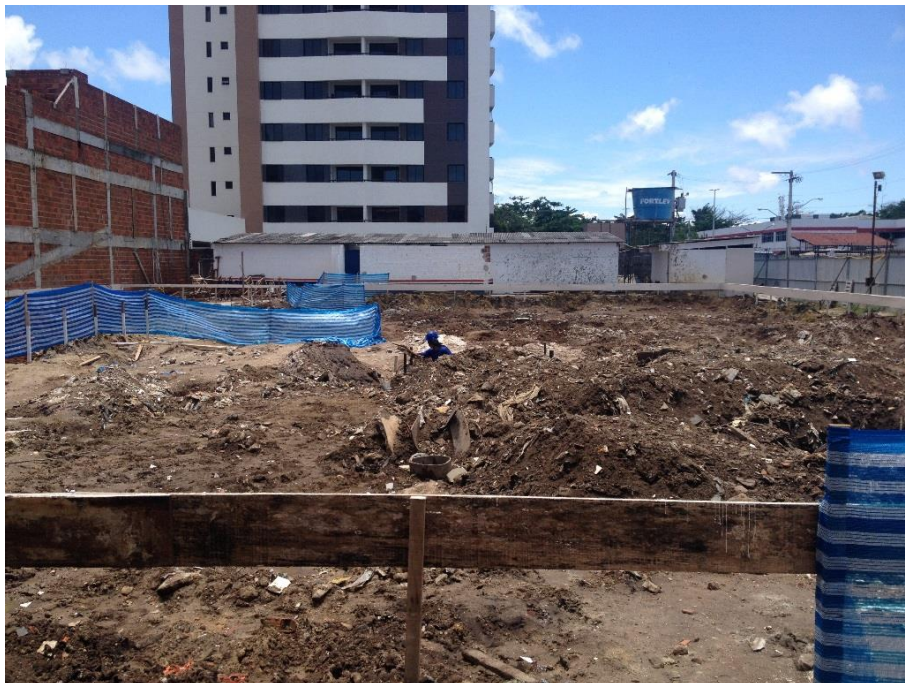
Figura 02: Terreno onde foi executado o prédio
