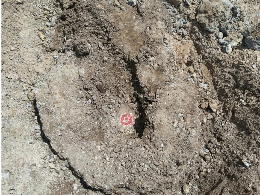
Figura 04 - Locação de estaca
