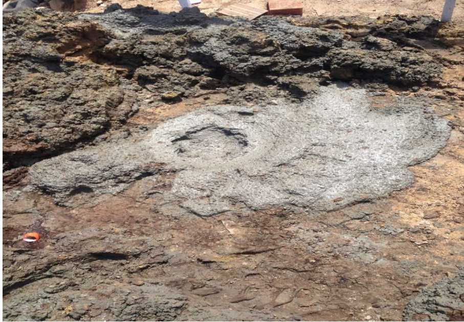
Figura 07: Concretagem das estacas
