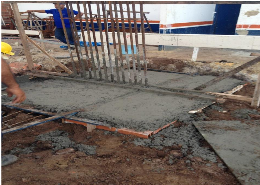
Figura 12: Concretagem de blocos
