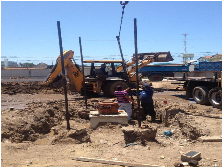
Figura 03: Limpeza do terreno
