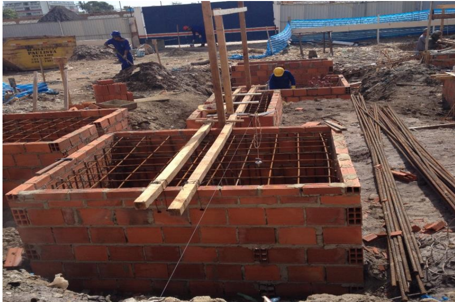
Figura 09: Blocos de coroamento
