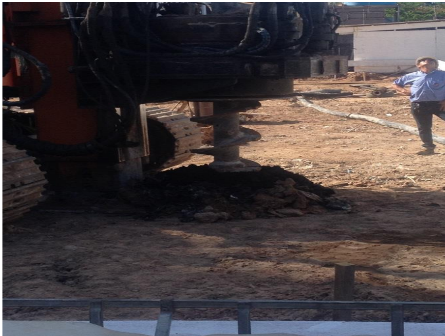
Figura 06: Perfuração das estacas
