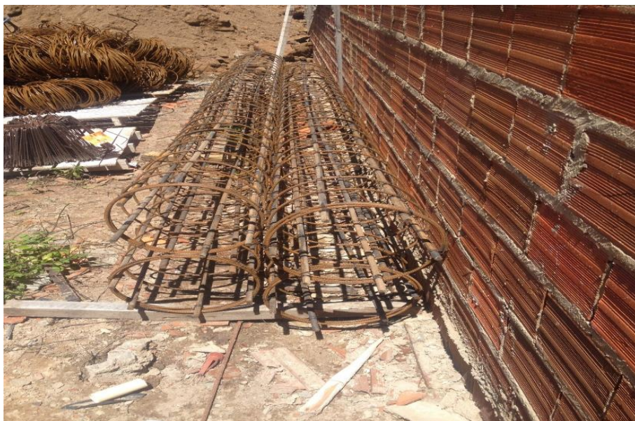
Figura 10: Acompanhamento dos serviços de armação das ferragens
