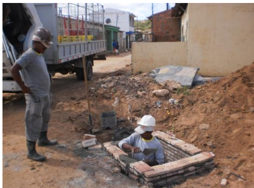
Foto 14 – Execução de boca de lobo.
