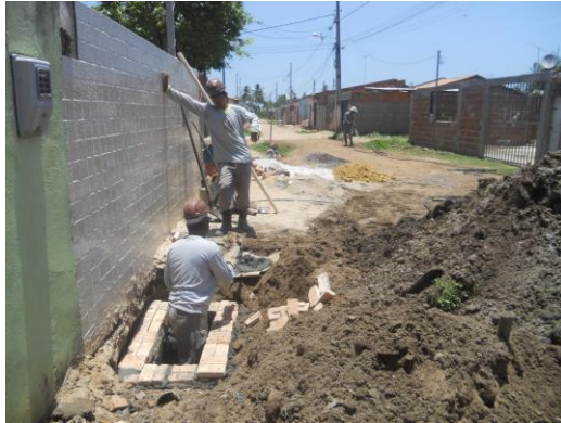
Foto 15 – Execução de boca de lobo.
