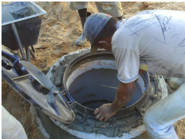
Foto 19 - Assentamento do tampão de ferro fundido.
