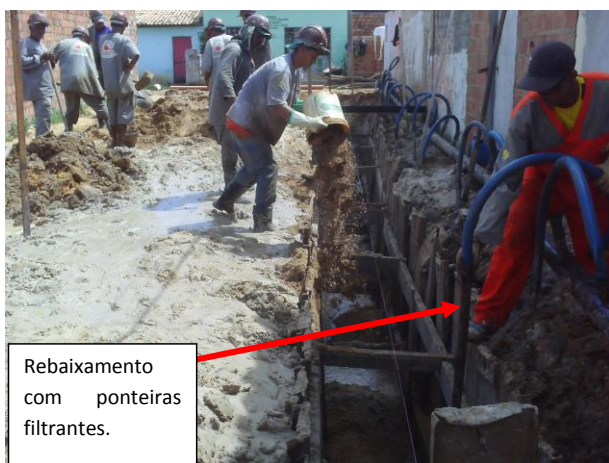
Foto 05 – Vista do Rebaixamento com Ponteiras Filtrantes a vácuo.
