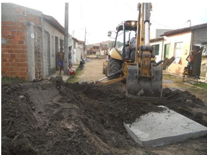
Foto 13 – Poço de Visita para drenagem pluvial.
