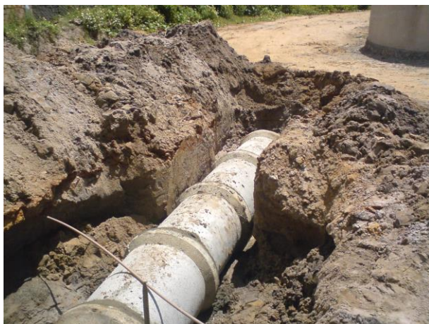
Foto 06 – Vista de trecho de drenagem Pluvial em execução
