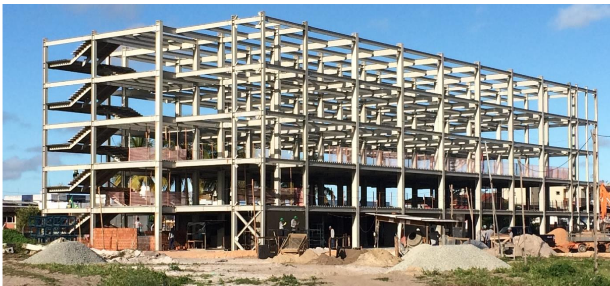
Figura 08 – Montagem dos Perfis Horizontais e Verticais
