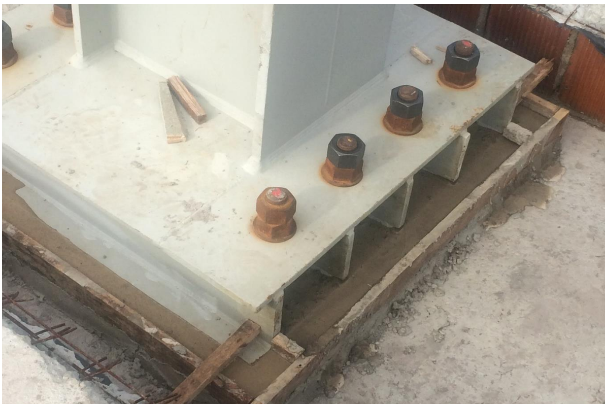
Figura 03 – Montagem de arruelas, porcas, contra porcas
