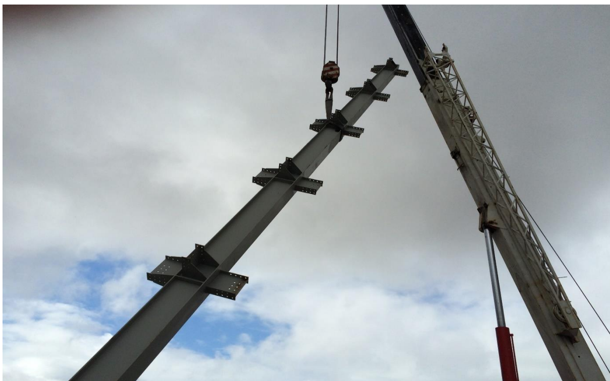
Figura 02 – Içamento do pilar para base de fundação.
