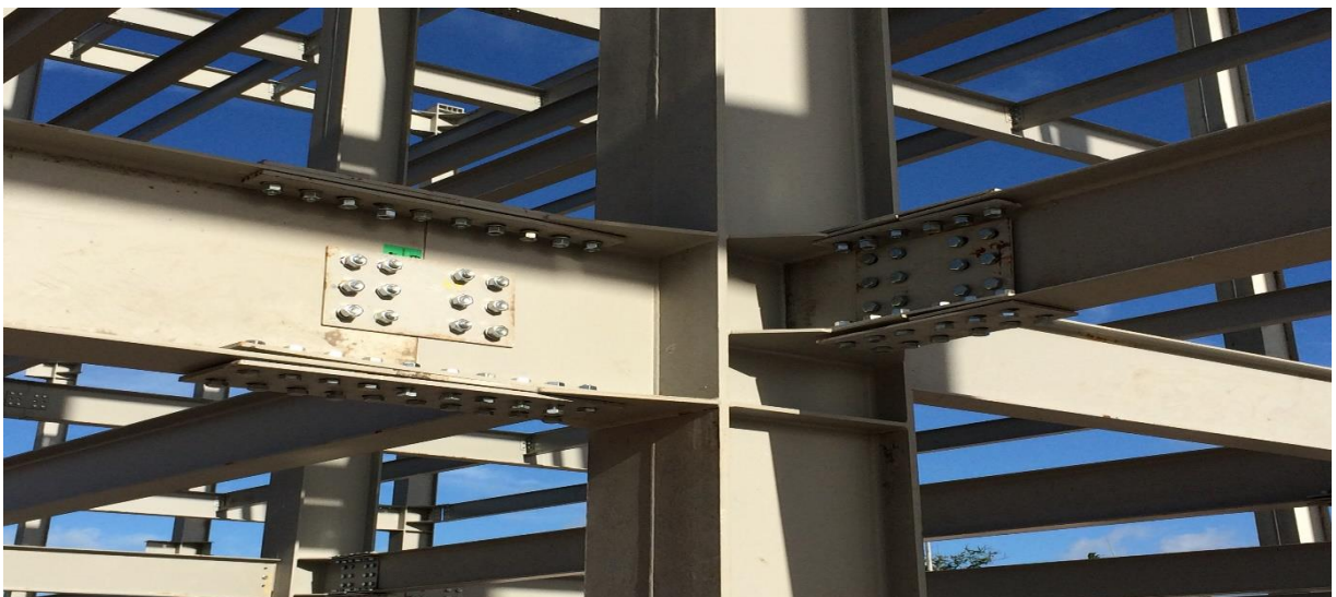
Figura 06 – Fixação de Vigas Principais e Secundarias
