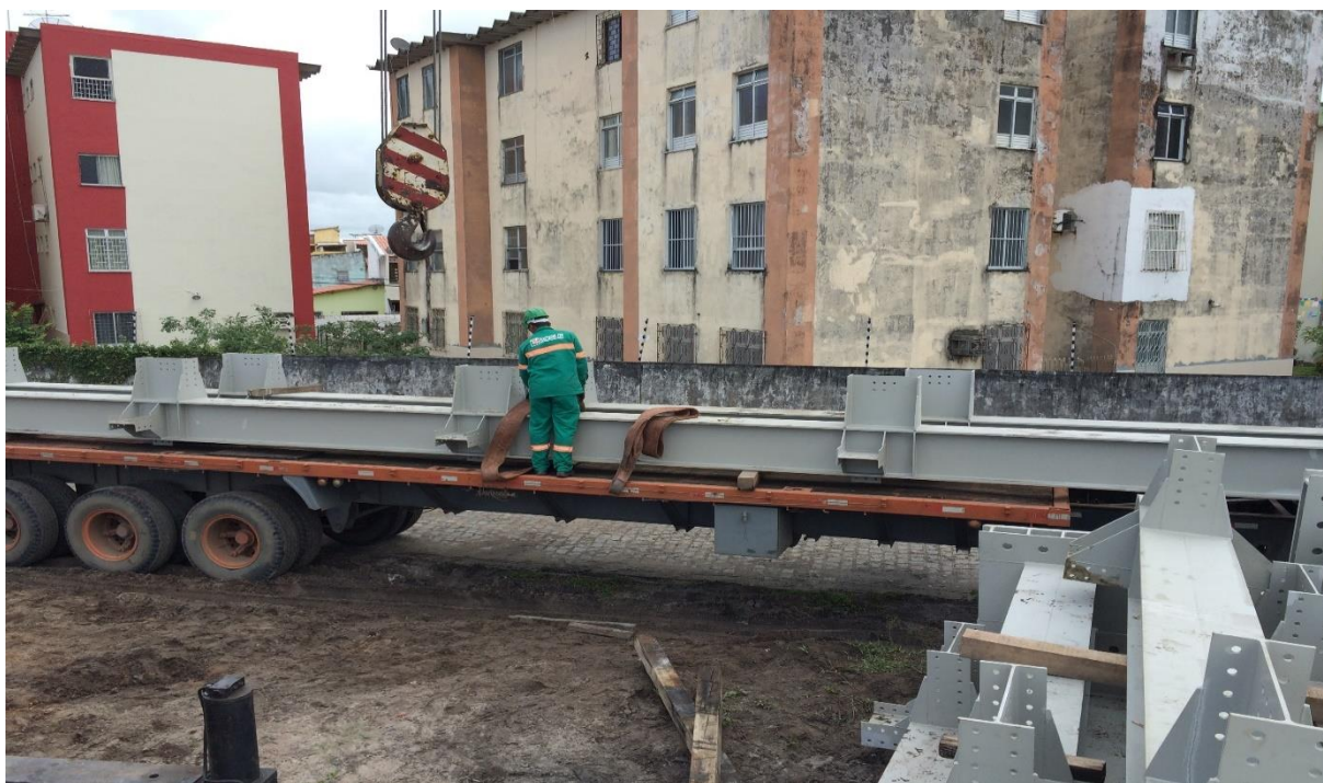
Figura 01 – Descarregamento de Perfis
