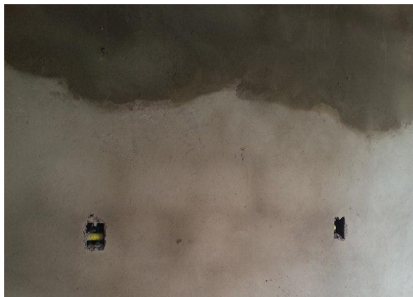
Figura 7. Execução de Reboco em Paredes Internas Fonte: Arquivo Pessoal.
