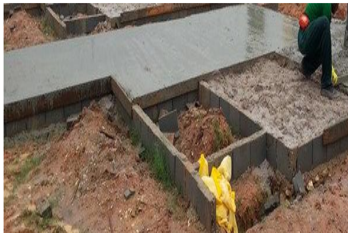
Figura 5. Concretagem da Camada Impermeabilizadora Fonte: Arquivo Pessoal.
