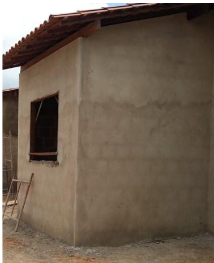
Figura 6. Execução do Reboco em Paredes Externas Fonte: Arquivo Pessoal.
