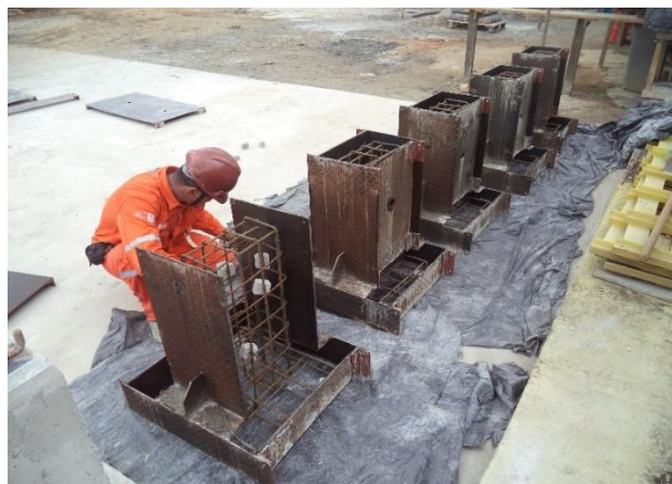
Figura 17 - Armaduras dentro das formas.
