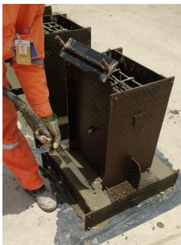
Figura 27 - Vibração do concreto.
