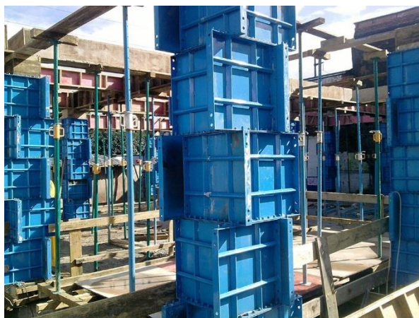
Figura 3- Forma em aço para pilares.
