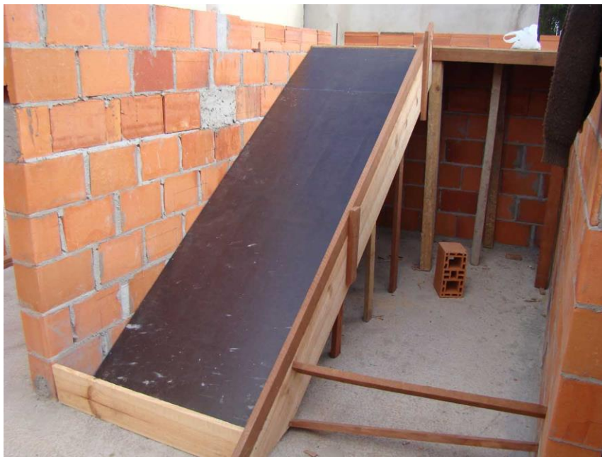
Figura 4 - Forma em madeira para confecção de escada.
