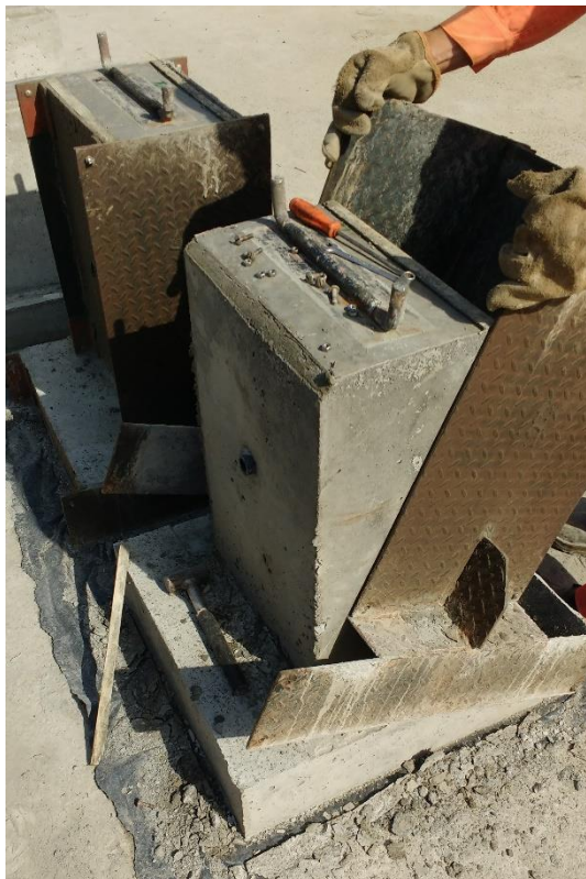
Figura 30 - Desmoldagem dos artefatos pré-moldados. Fonte: Acervo do autor, 2015.
