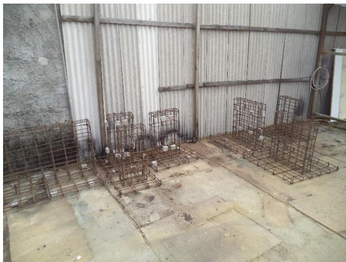
Figura 16- Armaduras montadas.
