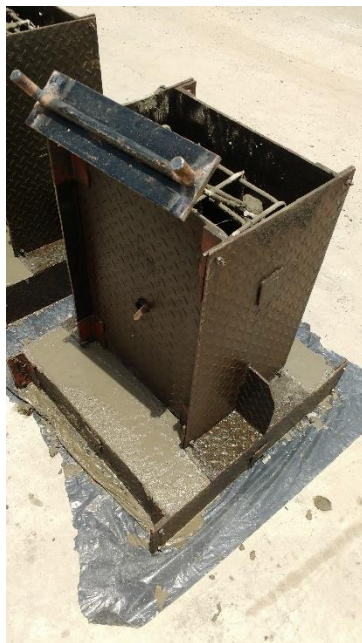
Figura 24 - Concretagem das bases. Fonte: Acervo do autor, 2015.
