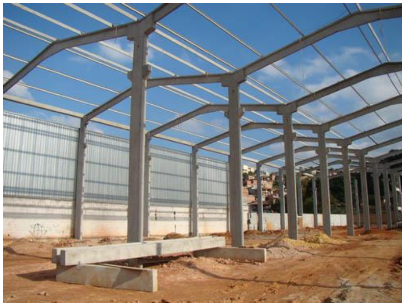
Figura 1 - Estrutura totalmente confeccionada em elementos estruturais pré-fabricados.
