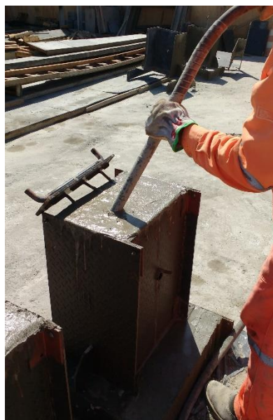
Figura 25 - Concretagem dos pescoços. Fonte: Acervo do autor, 2015.
