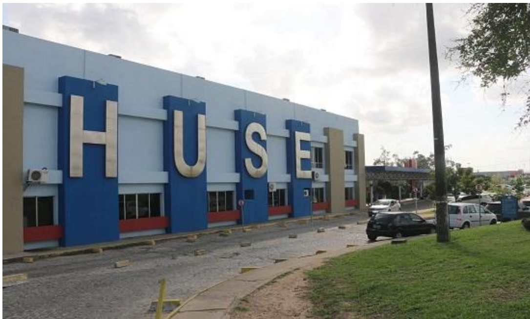
18 Figura 5 – Fachada do HUSE
