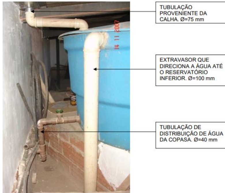
Figura 06: Posicionamento da tubulação em um dos reservatórios superiores.
