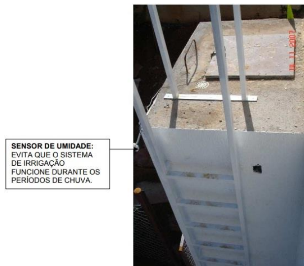
Figura 03: Acesso ao reservatório inferior.
