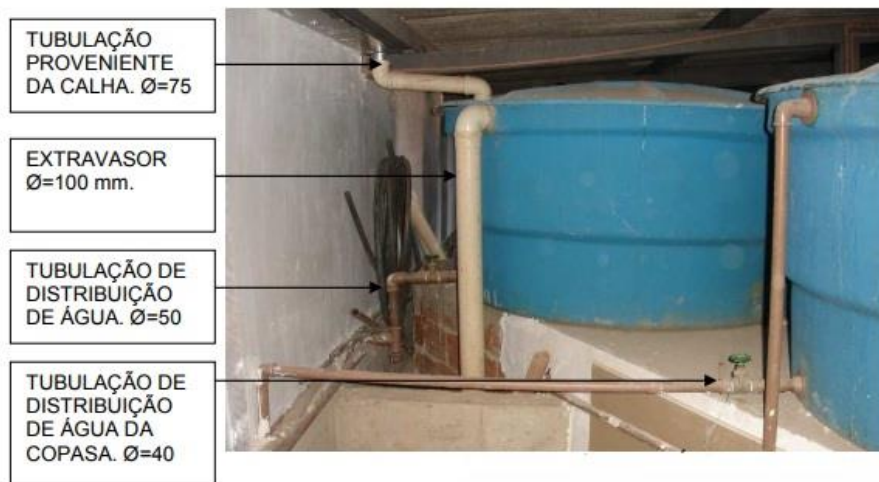
Figura 02: Reservatórios superiores.
