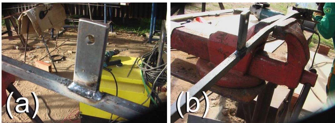
Figura 3.40. (a) FC3 soldada em FC1; (b) FC1 presa na morsa.
