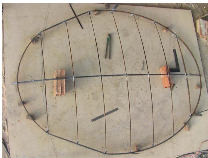
Figura 3.56. O refletor do concentrador solar montado e apoiado sobre tijolos e quadrados de madeira.
