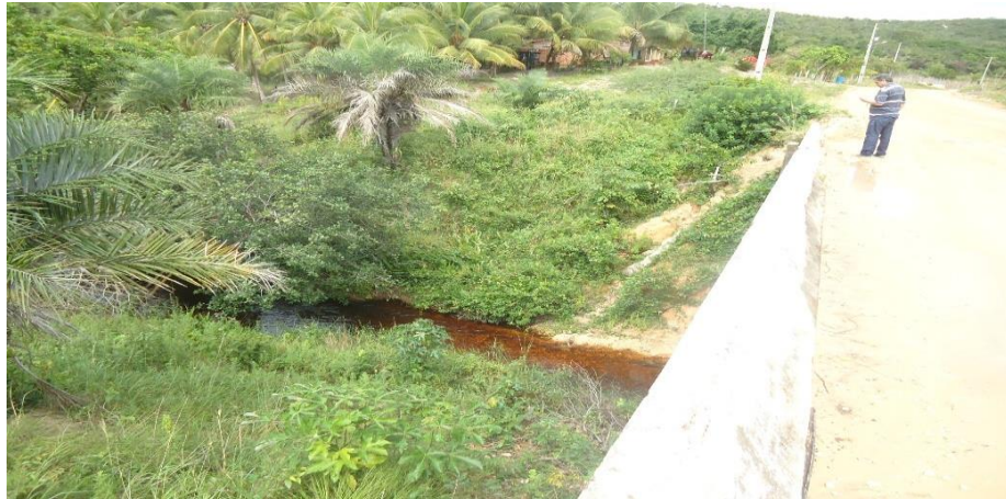
Figura 28 Ponte sobre o Rio Aningas Rodovia SE 100 Bacia Costeira do Sapucaia Fonte: Autor, 2014
