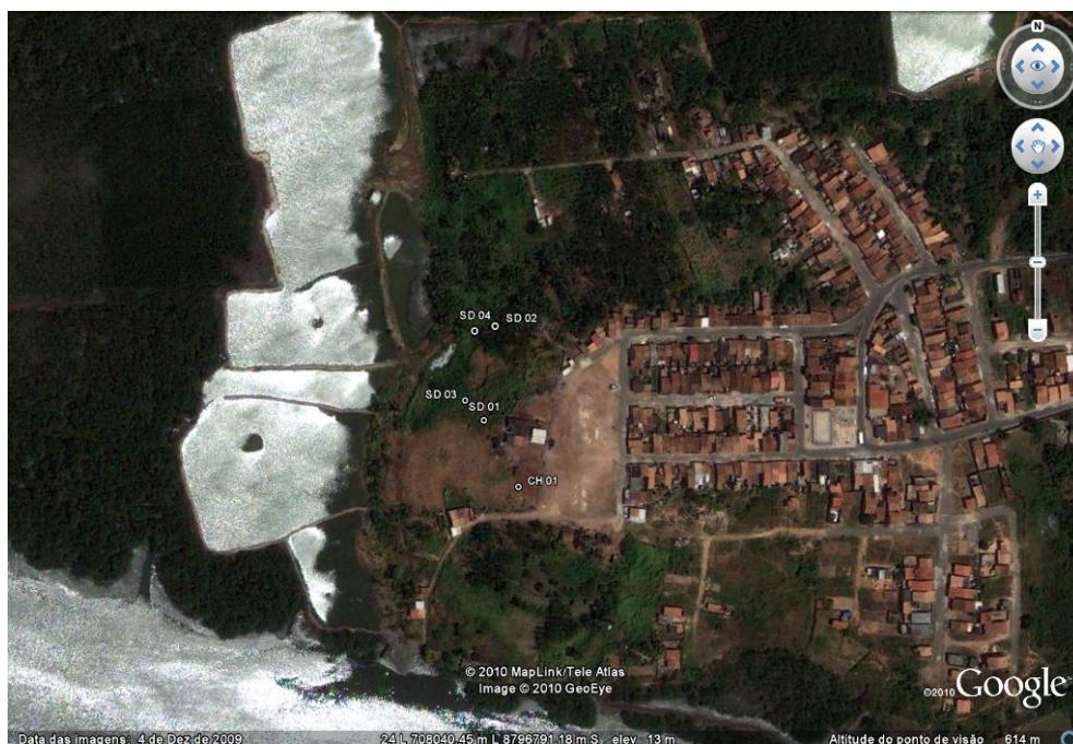
Figura 1.2 - Localização dos pontos de referência coletados da antiga lixeira do bairro Soledade, Aracaju/Se, 2009. Fonte: http://earth.google.com/intl/pt-BR
