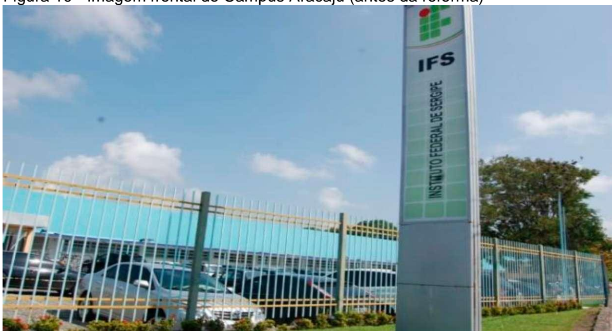
Figura 10 - Imagem frontal do Campus Aracaju (antes da reforma)
