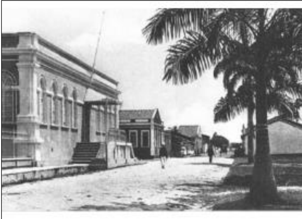
Figura 3 - Fachada frontal do colégio Atheneu Sergipense, 1873–1875. Praça Olímpio Campos 18 Fonte: PREFEITURA MUNICIPAL DE ARACAJU, 2015.
