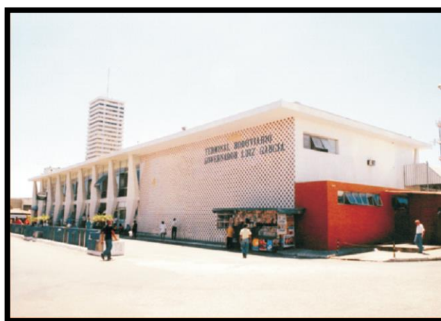
Fig. 23: Aspectos da Estação Rodoviária Gov. Luiz Garcia, inaugurada em 31.01.1962 um ícone do movimento modernista em Aracaju. Fonte: PMA – Diagnostico para revisão do Plano Diretor, 2015.
