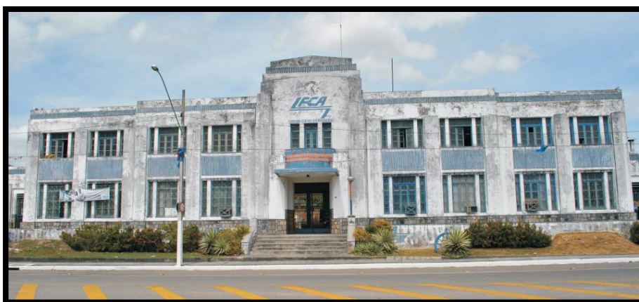
Fig. 20: Vista da fachada principal da Estação Ferroviária, em estilo Art Déco. Fonte: PMA – Diagnostico para revisão do Plano Diretor, 2015.
