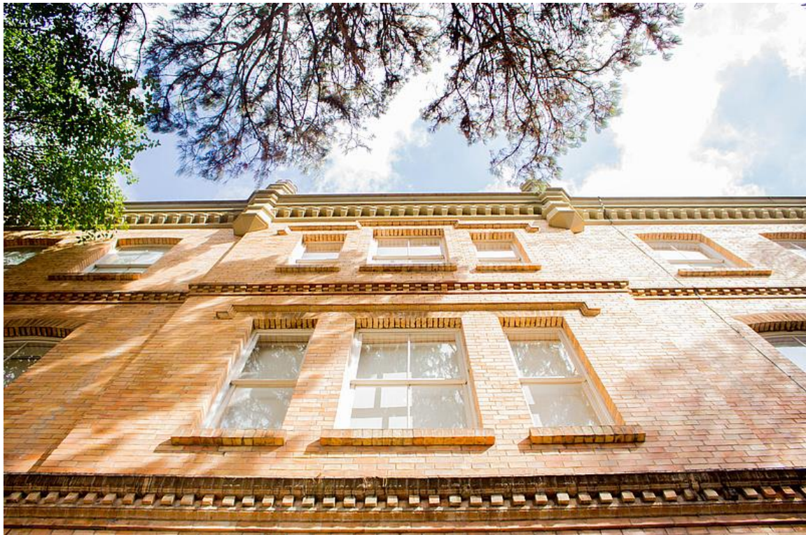
Figura 5: Prédio- Ed. John Theron Mackenzie
