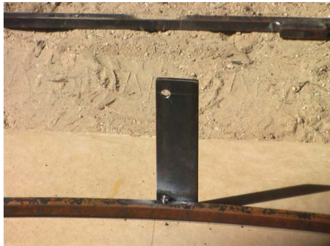
Figura 3.47. Soldagem de F5 em F2 sobre o gabarito de madeira. Detalhe para a linha no gabarito, que corresponde à linha 4
