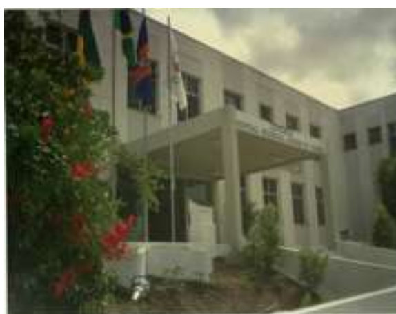
Figura 7: Fachada do Hospital à Rua Dr. Jessé Fontes, em 2004
