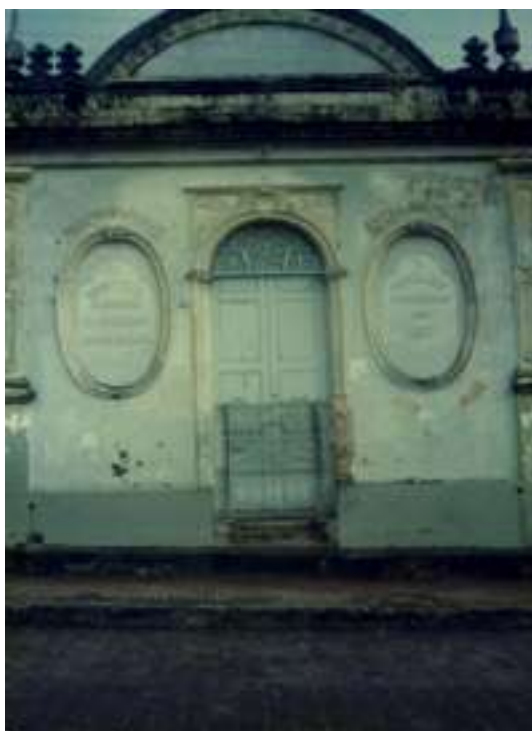
Figura 3: Fachada do Hospital à Rua Camerino
