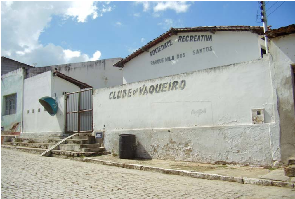
Foto 12: Vista parcial do Clube do Vaqueiro Fonte: Acervo de Anselmo Xavier
