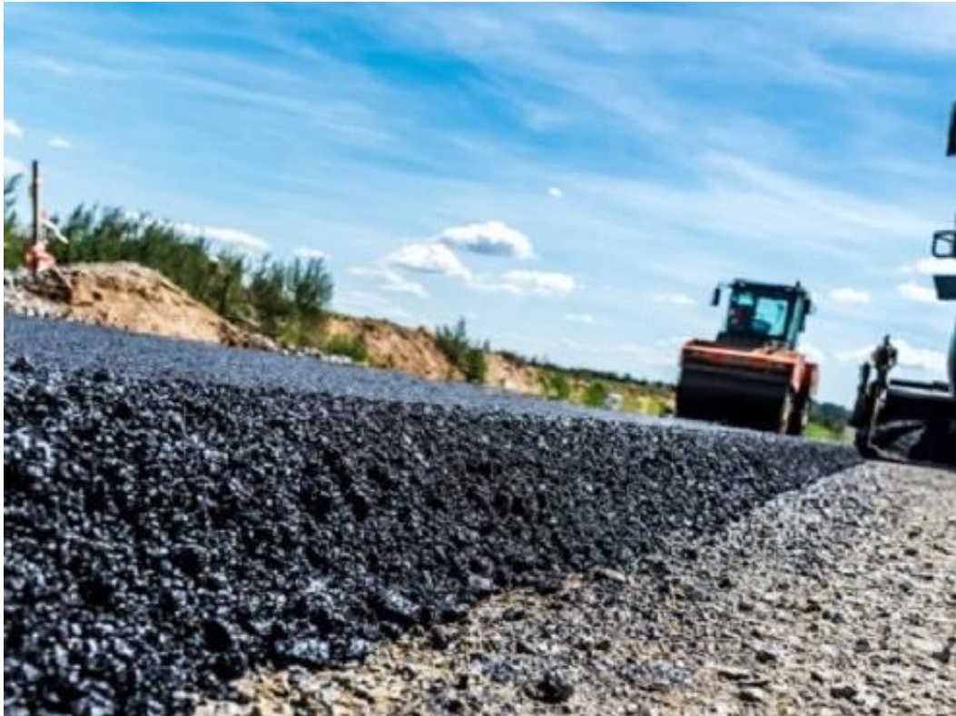
Figura 8 - Cimento asfáltico de baixo volume de tráfego.
