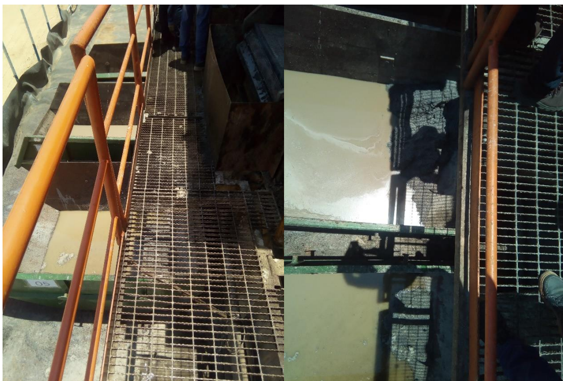
Figura 14: Caçamba de armazenamento de resíduos tóxicos.
