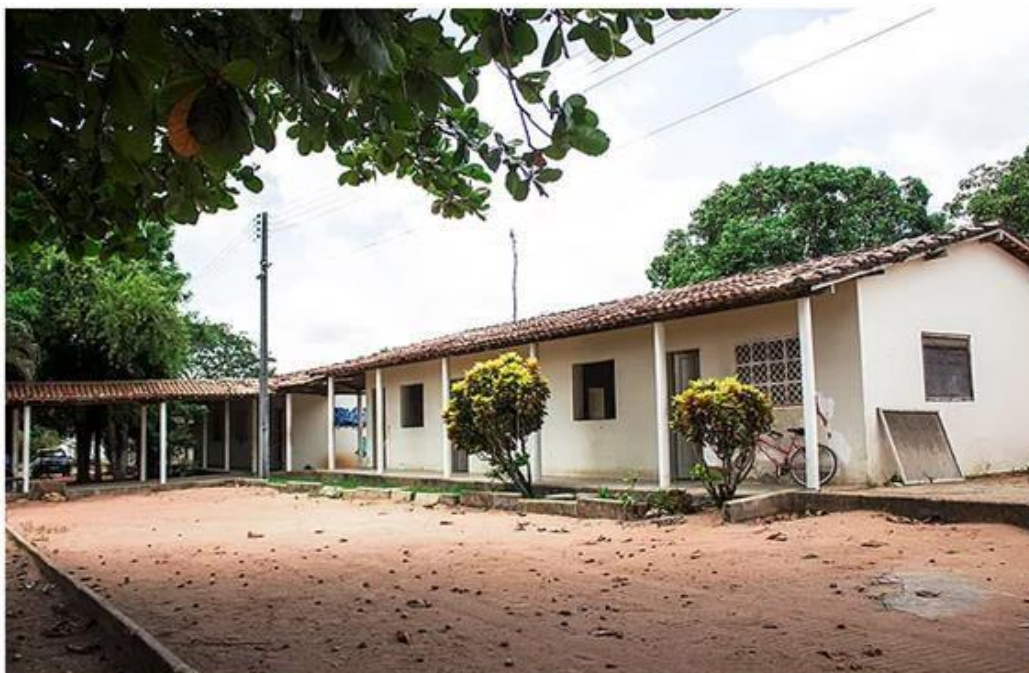
Figura 3 - Instalações da EFAL
