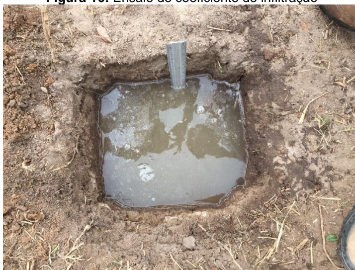
Figura 16: Ensaio de coeficiente de infiltração
