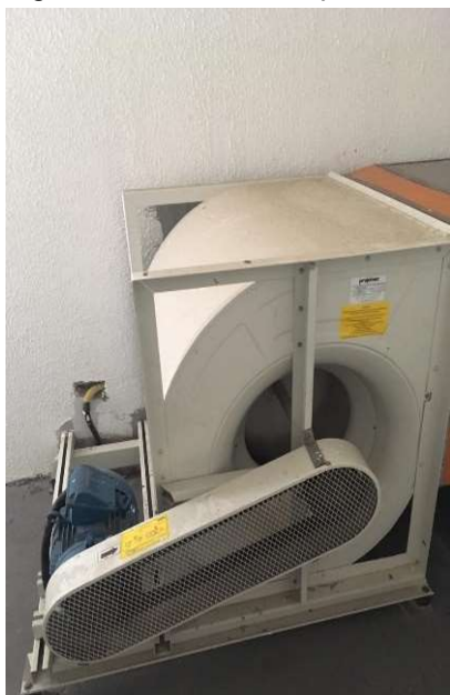
Figura 44 – Sistema de pressurização
