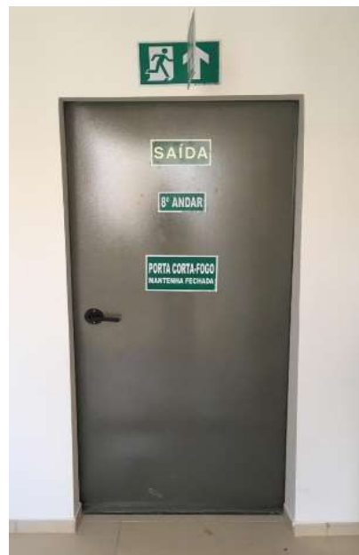
Figura 39 – Saída de emergência
