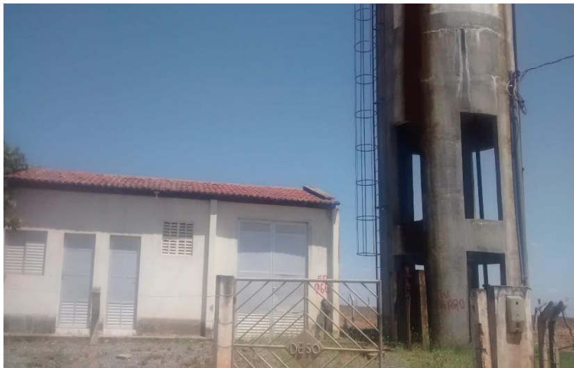
Figura 31: Reservatório RE1 ao lado da casa de apoio.
