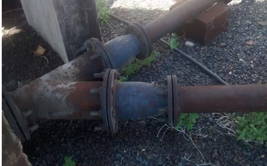
Figura 32: Terreno abaixo do reservatório coberto com brita.
