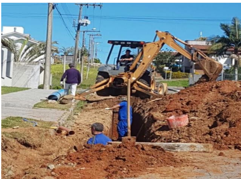
Figura 39: Implantação de adutora na cidade de Cocal do Sul.
