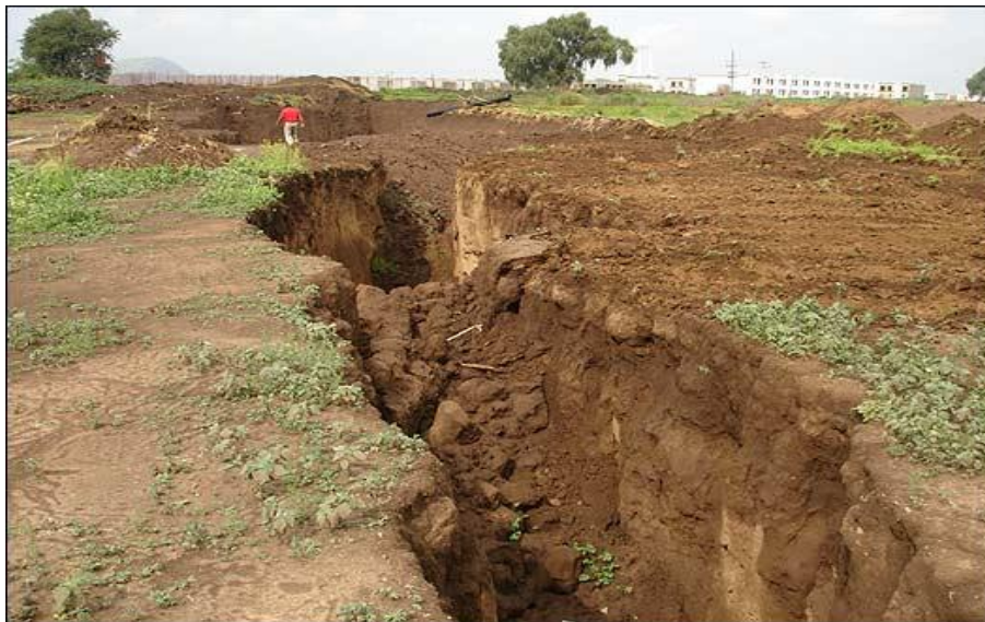
Figura 38: Solo rachado devido à erosão na cidade do México.
