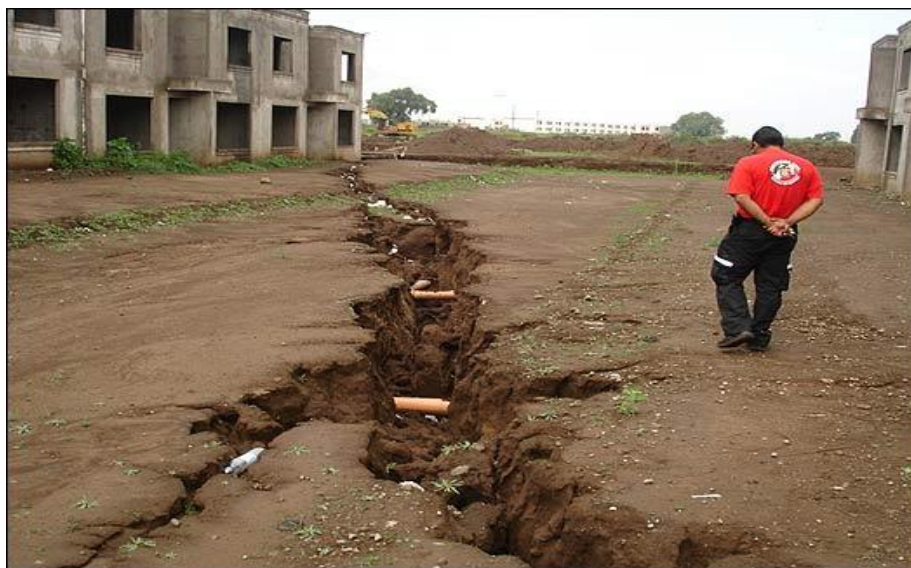
Figura 09: Rachadura no solo por conta da extração desordenada de água subterrânea no México.
