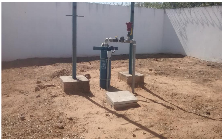
Figura 26: Poço 2 no interior da área de proteção.
