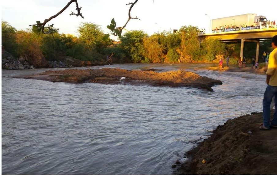
Figura 18: Canal da cidade de Monteiro (PB).
