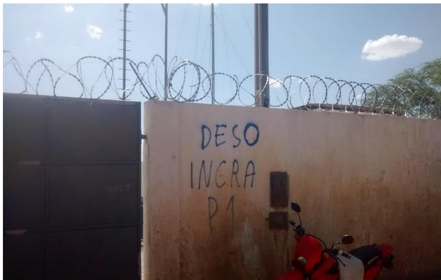
Figura 22: Estrutura de proteção dos poços.
