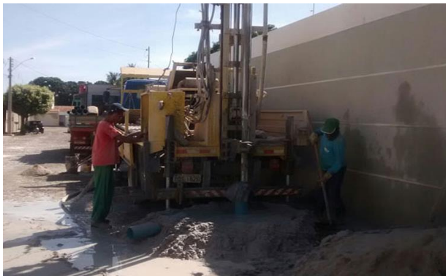
Figura 11: Implantação de Poço artesiano.
