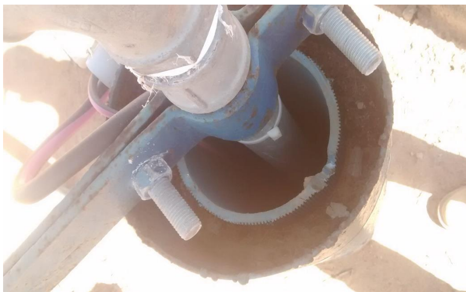
Figura 43: Detalhe da chapa vertical metálica.
