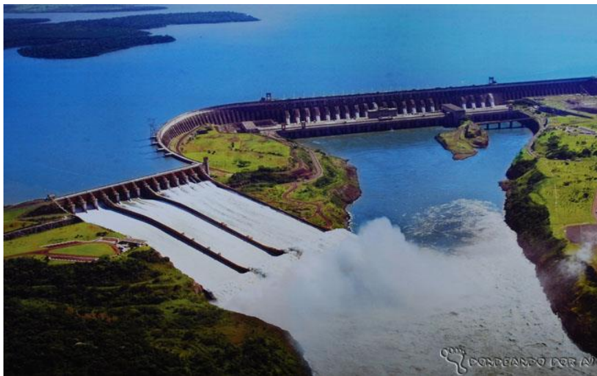
Figura 13: Usina de Itaipu.
