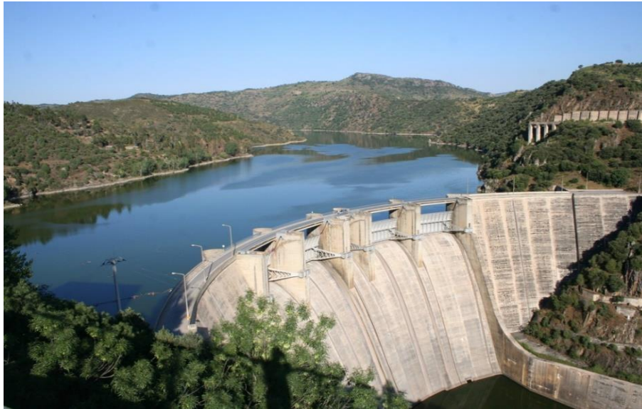
Figura 12: Barragem da Bemposta.
