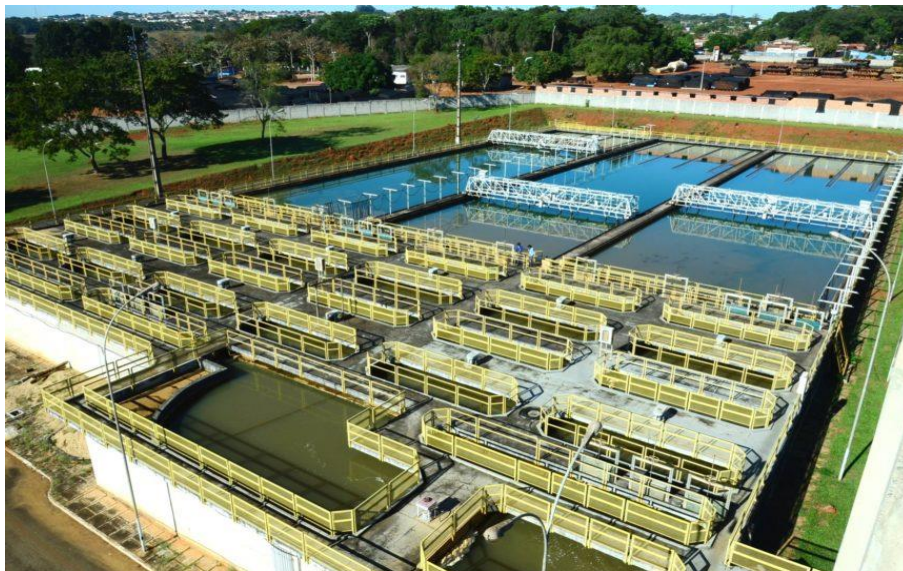
Figura 19: Estação de tratamento de água.
