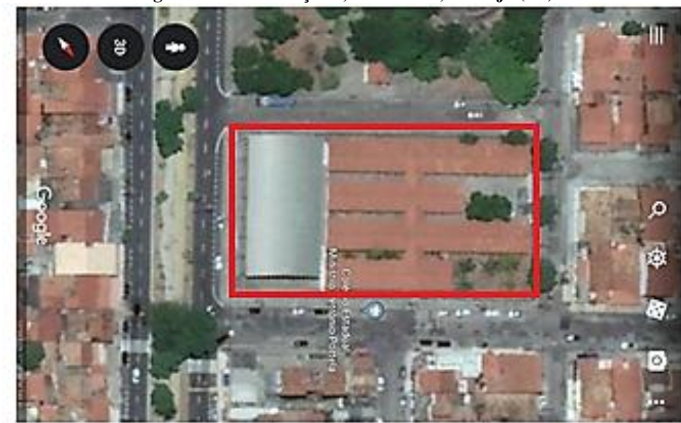
Figura 14 – Construção 4, Farolândia, Aracaju (SE).
