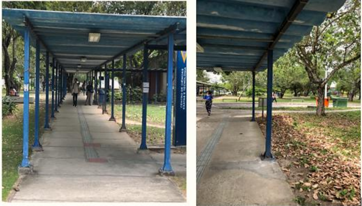
Figura 22 - Pilares de sustentação de cobertura de passarela.
