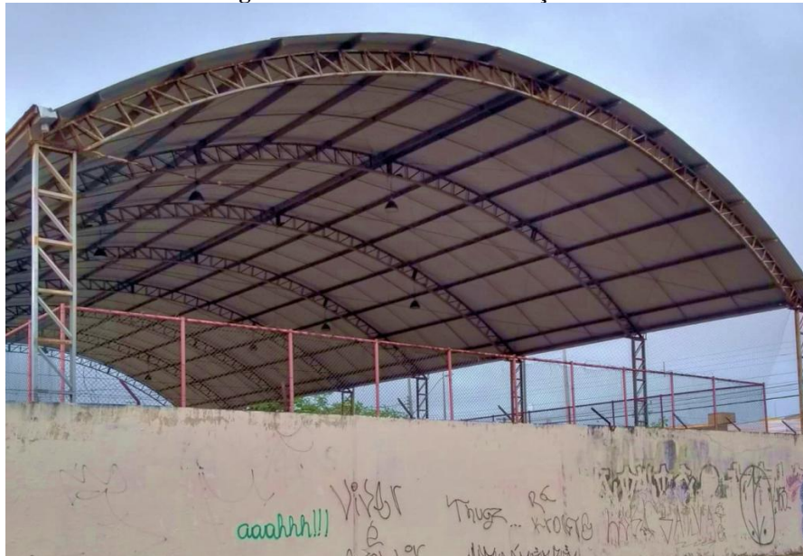
Figura 24 - Detalhe da Construção 4.
