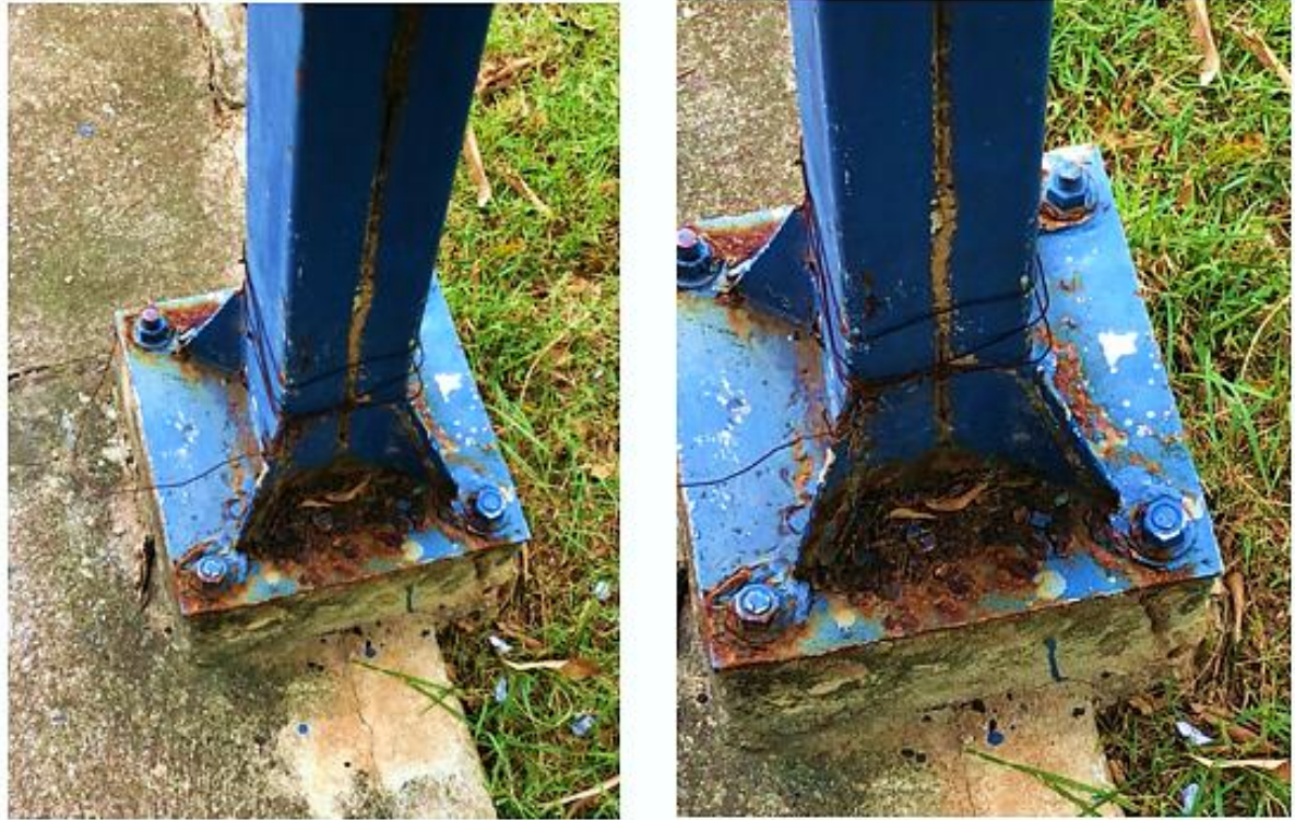
Figura 23 - Fixações dos pilares das passarelas.
