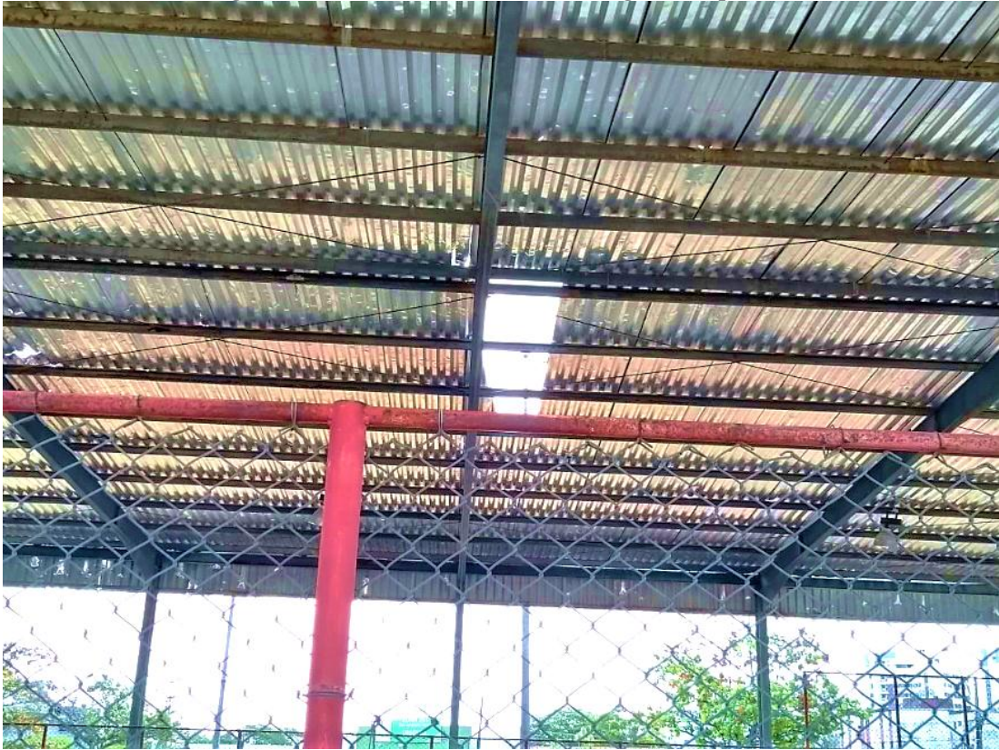
Figura 29 - Ponto sem cobertura e vista geral da quadra.
