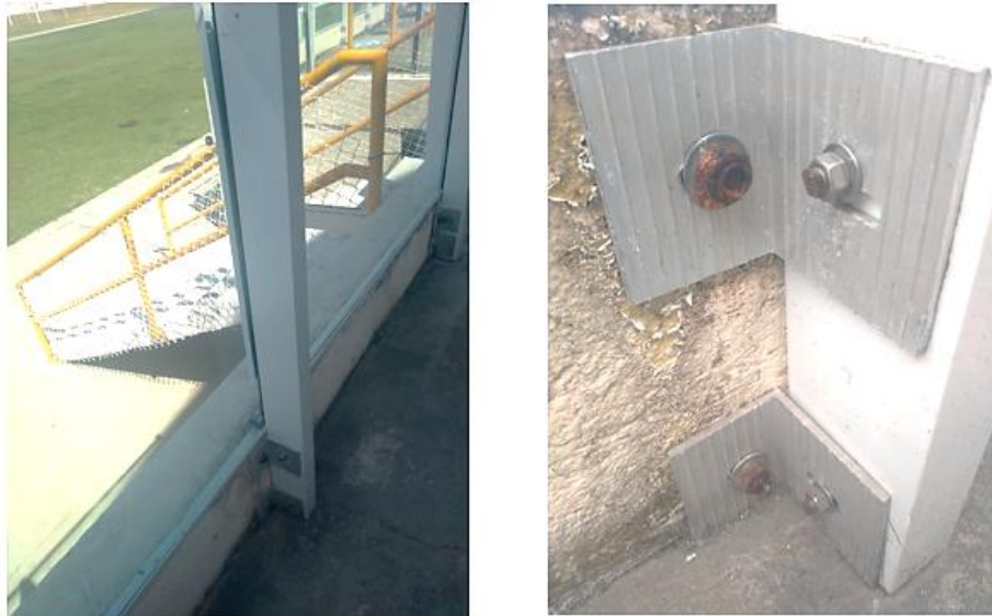
Figura 20 - A) Guarda-corpos da Construção 2. B) Parafusos dos guarda-corpos.
