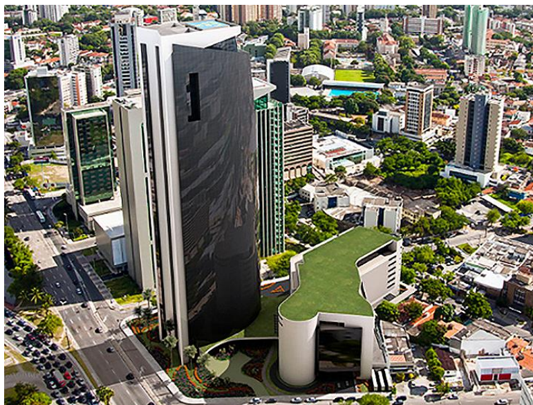
Figura 10 - Edifício-garagem Empresarial Charles Darwin com oito andares em Recife.
