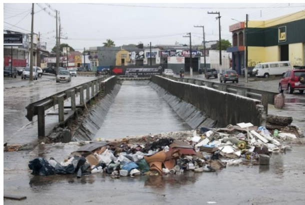
Figura 31 - Resíduos sólidos no canal Gonçalo Prado Rolemberg.
