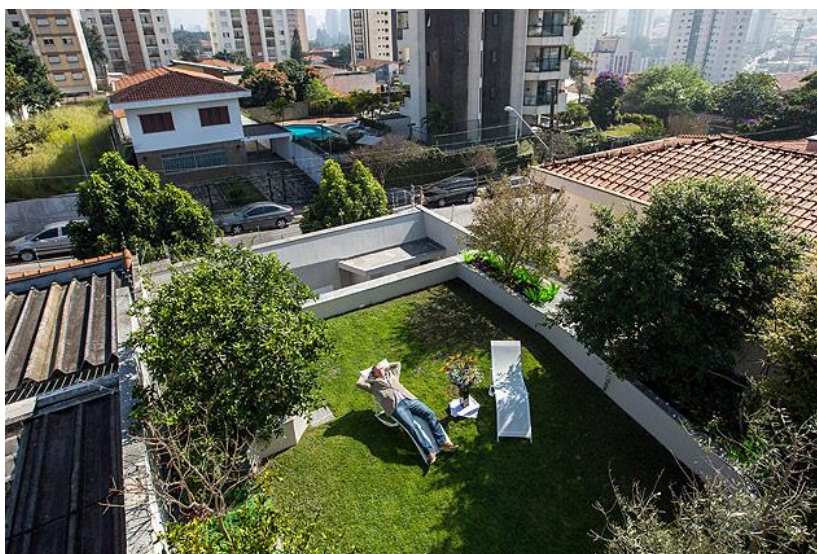
Figura 15 - Exemplo de lazer no telhado verde.
