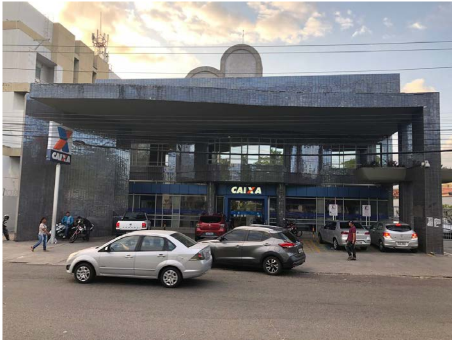
Figura 22 – Fachada principal do Banco Caixa Econômica Federal
