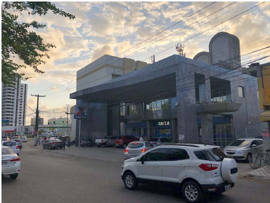
Figura 23 – Fachada lateral do Banco Caixa Econômica Federal
