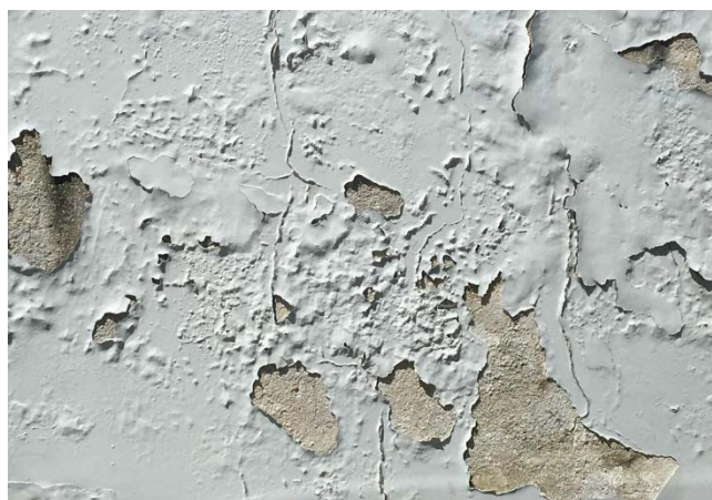
Figura 32 – Muro de divisa do Banco Caixa Econômica Federal I
