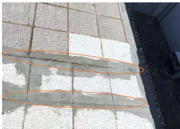
Figura 29 – Laje superior do Banco Caixa Econômica Federal
