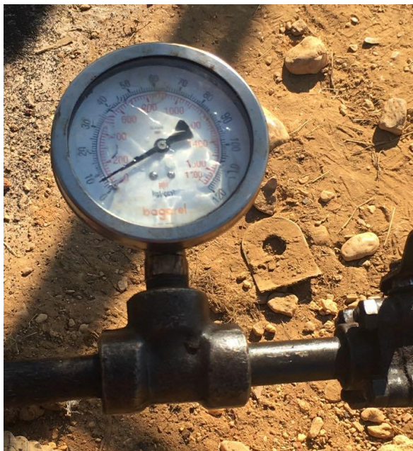
Figura 13 - verificação da pressão no manômetro.
