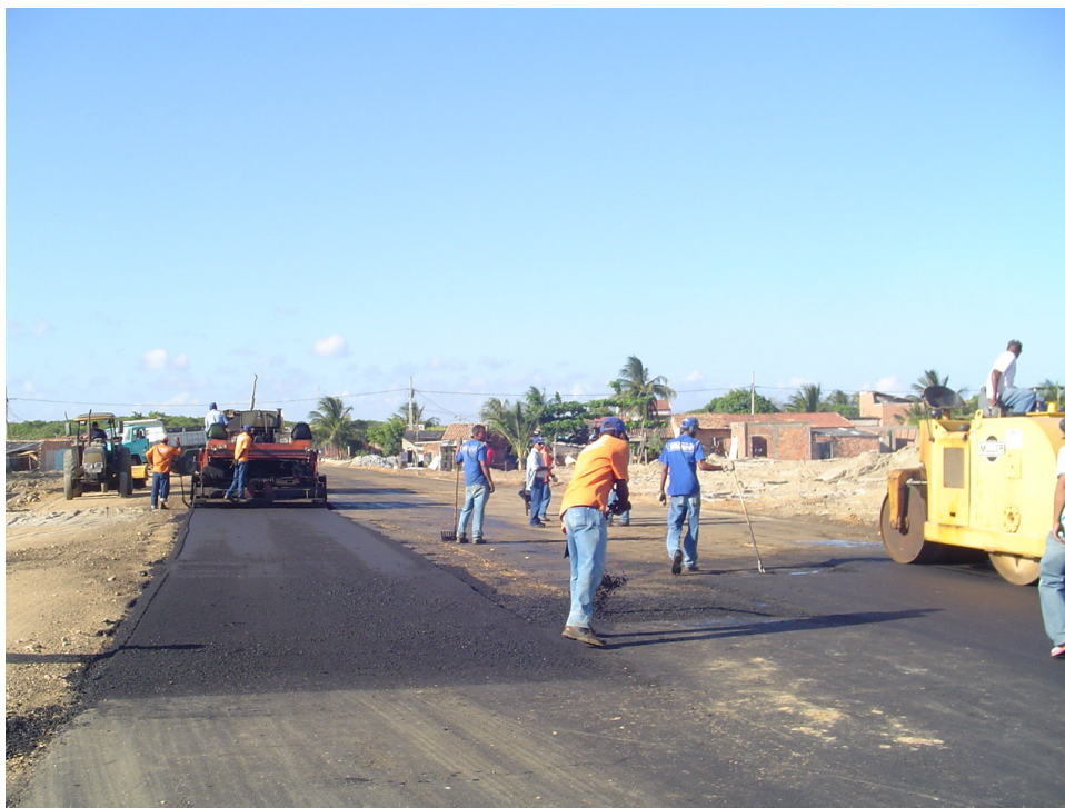
Construção da avenida principal
