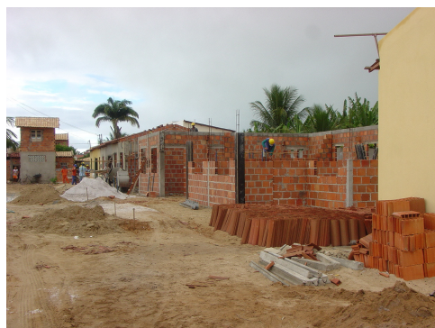
construção de residências
