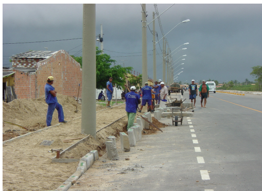
Construção da avenida
