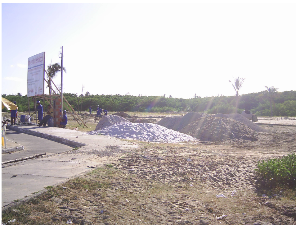
Construções da quadra poliesportiva do bairro Coroa do Meio
