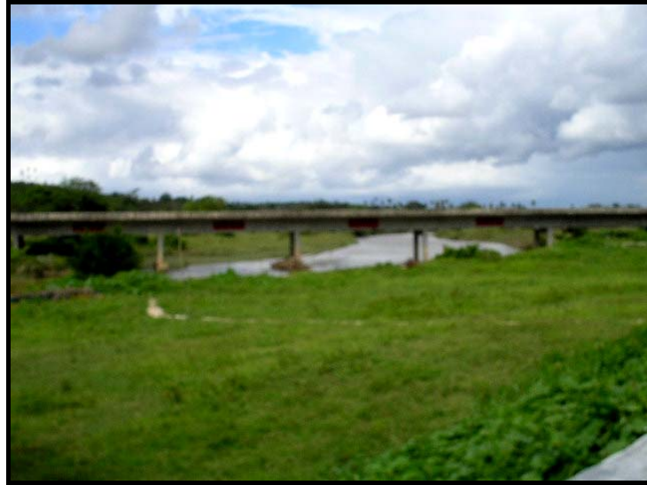
Figura 05 - Ponte sobre o Vaza-Barris em Itaporanga d' Ajuda
