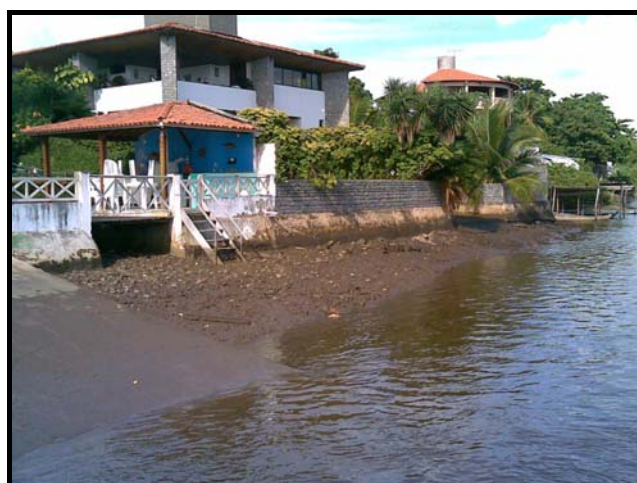
Figura 05: Casas construídas as margens do rio Vaza-Barris
