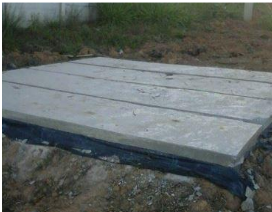
Figura 11 — Tampa das caixas em concreto armado Fonte: (TAIZES, 2015)
