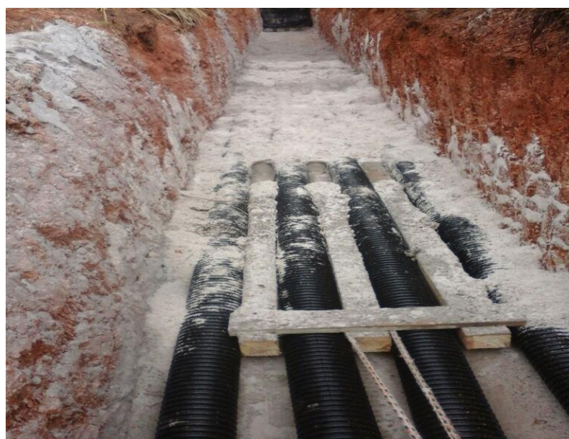
Figura 04 — Recebimento da tubulação Fonte: (TAIZES, 2015)
