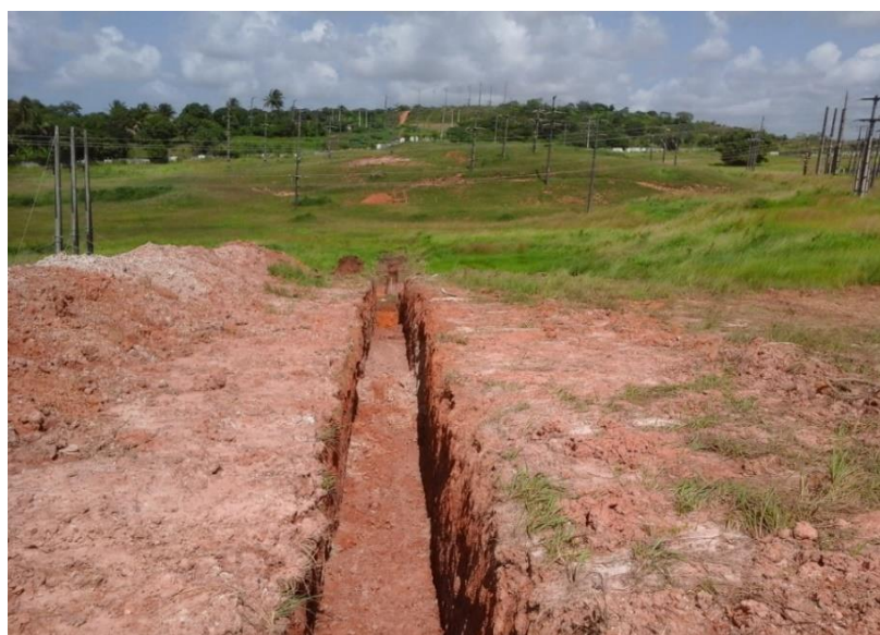
Figure 02 — Escavação com retroescavadeira Fonte: (TAIZES, 2015)
