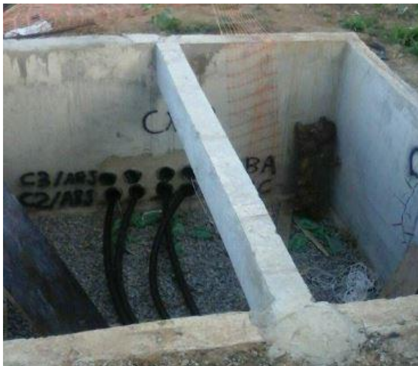
Figura 10 — Caixa com viga e tubulação Fonte: (TAIZES, 2015)
