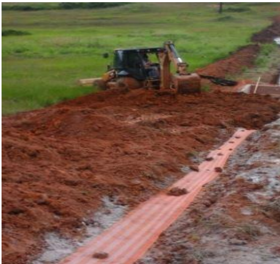
Figura 06 — Reaterro da vala com retro Fonte: (TAIZES, 2015)
