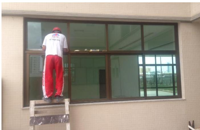
**Figura 04 - Assentamento de Esquadria Metálica e Vedação**
