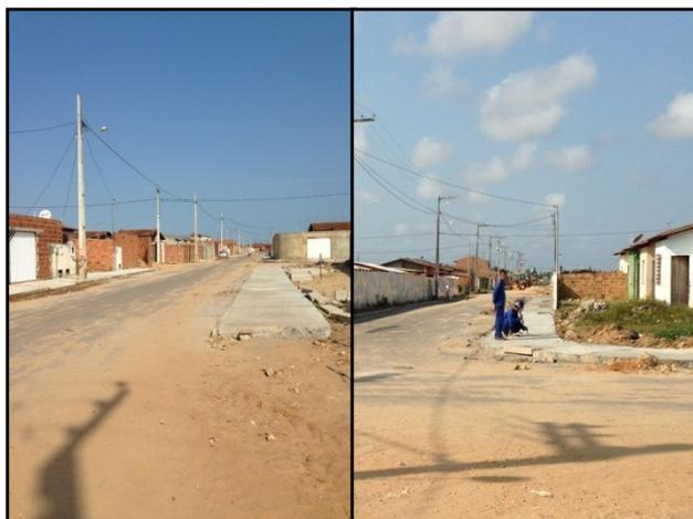
Figura 13 - Construção de calçada em concreto simples com  $f_{ck} = 15 \text{ Mpa}$  – Acesso 09 e Acesso 20
