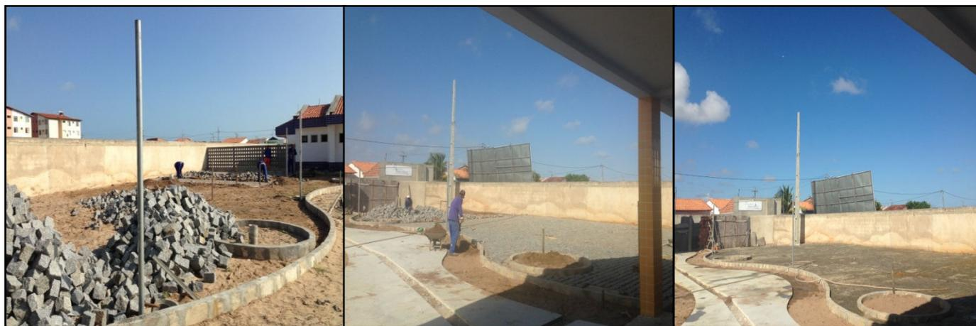
Figura 08 - Fases da execução e conclusão do estacionamento com paralelepípedo – Estacionamento -Área externa
