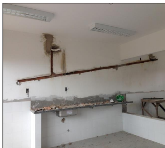
Figura 04: Execução da colocação da tubulação para ar condicionado. Fonte: Arquivo pessoal
