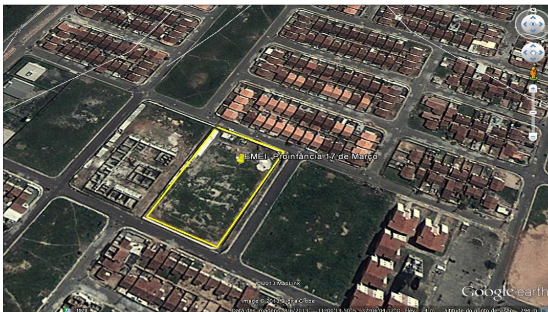
Figura 01 - Vista parcial do local da obra EMEI, situado Avenida Projetada – 17 de Março, Aracaju/SE, 49069-057
