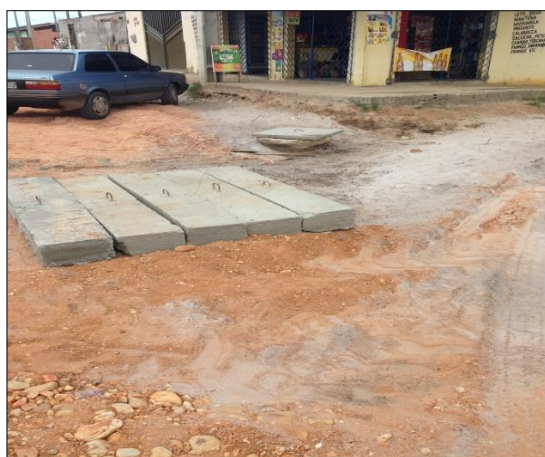
Figura 11: regularização dos poços de visita e bocas de lobo Fonte: Arquivo pessoal.
