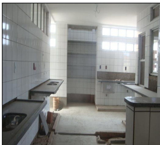
Figura 03: Assentamento de cerâmica nas paredes. Fonte: Arquivo pessoal
