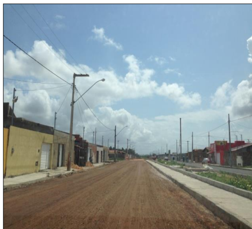
Figura 08: Colocação de material de base e sub base . Fonte: Arquivo pessoal
