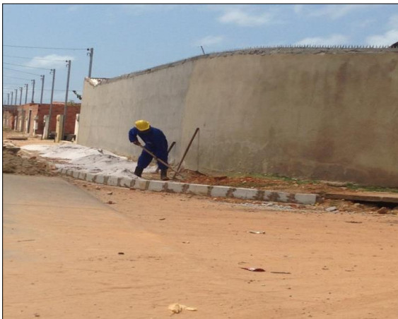
Figura 12: Construção de calçada. Fonte: Arquivo pessoal
