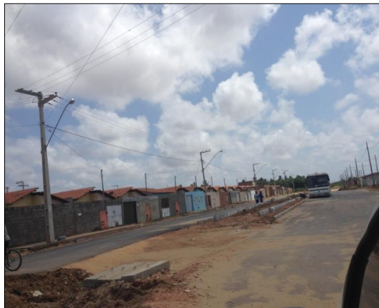
Figura 13: Execução do meio fio. Fonte: Arquivo pessoal
