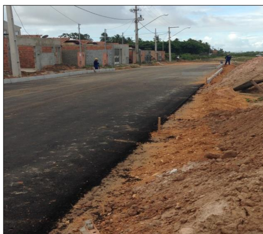
Figura 10: Imprimação e Asfalto. Fonte: Arquivo pessoal.
