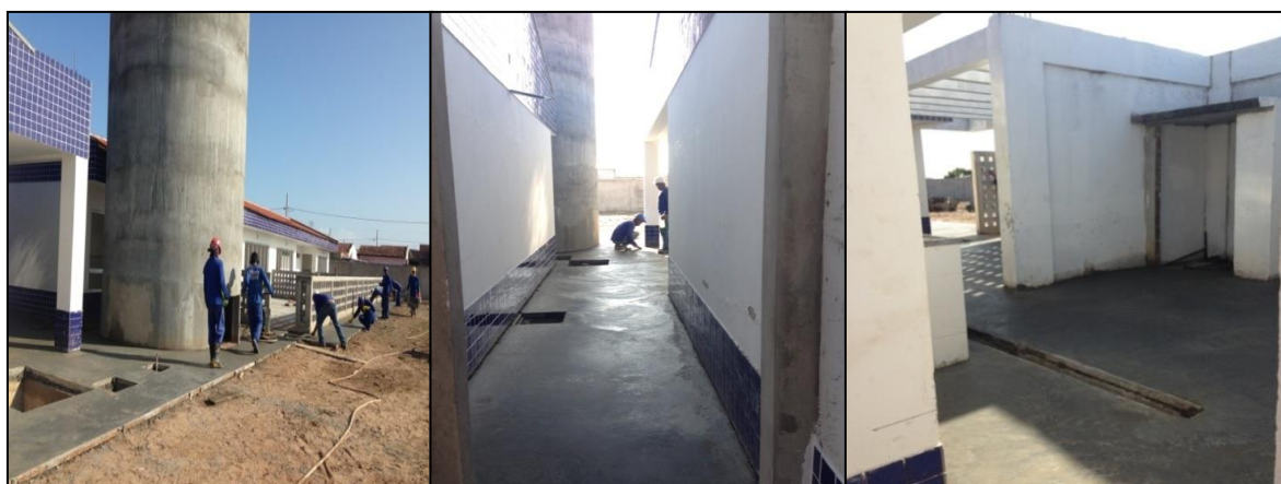
Figura 06: Execução de piso desmoldado mecanizado. Fonte: Arquivo pessoal
