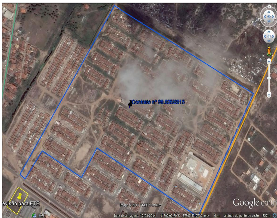
Figura 07 - Vista parcial do local da obra Complementação da Infraestrutura no Bloco 02, Bairro 17 de Março, Aracaju/SE
