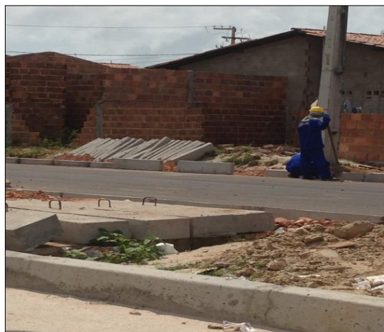
Figura 09: Confeção do meio fio. Fonte: Arquivo pessoal
