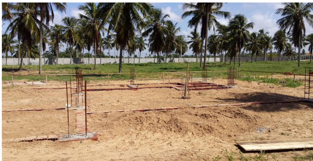
Figura 2 - Reaterro e execução das bases para as vigas baldrame.
