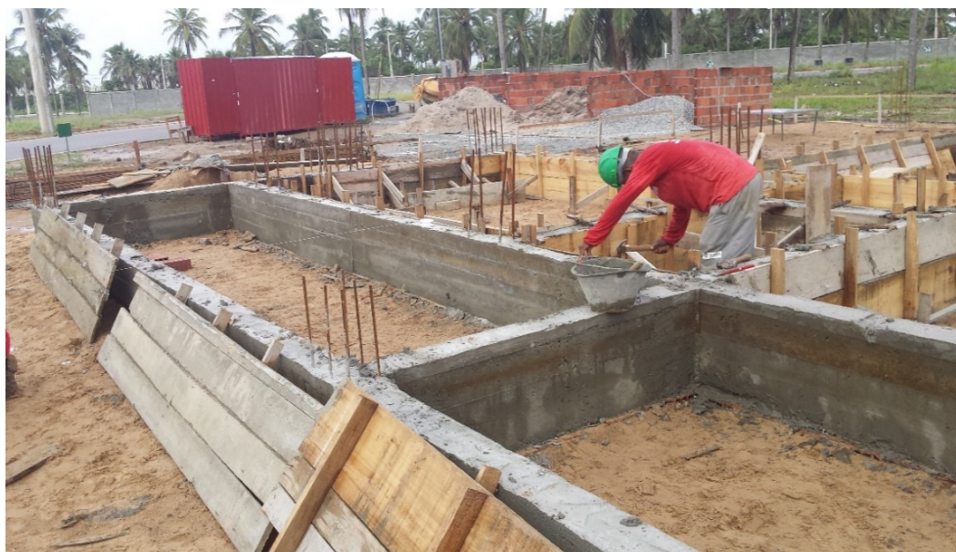
Figura 4 - Desforma das vigas baldrames.
