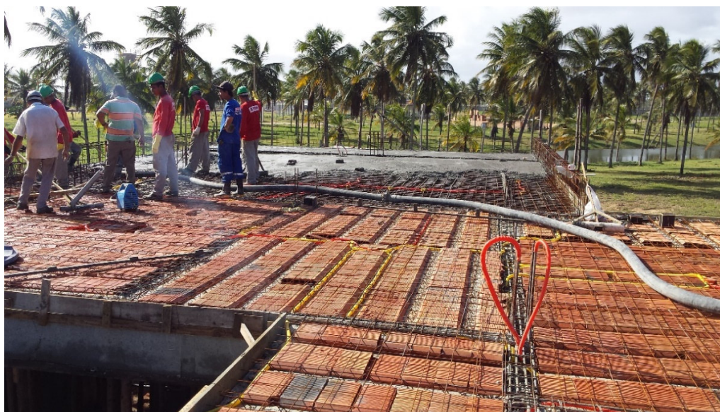
Figura 13 - Concretagem da laje pré-moldada
