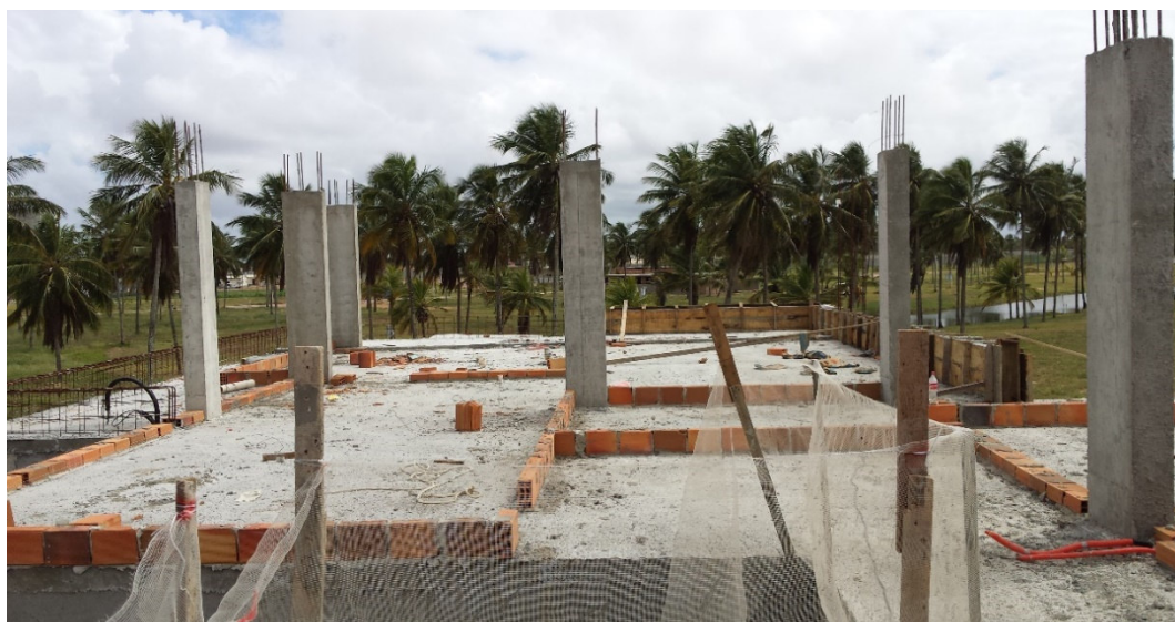
Figura 14 - Marcação da alvenaria do 2º pavimento
