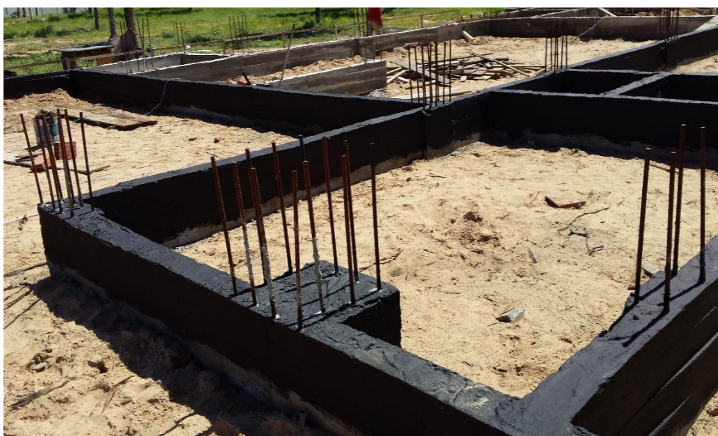
Figura 7 - Pintura das vigas baldrames com impermeabilização em tinta asfáltica.
