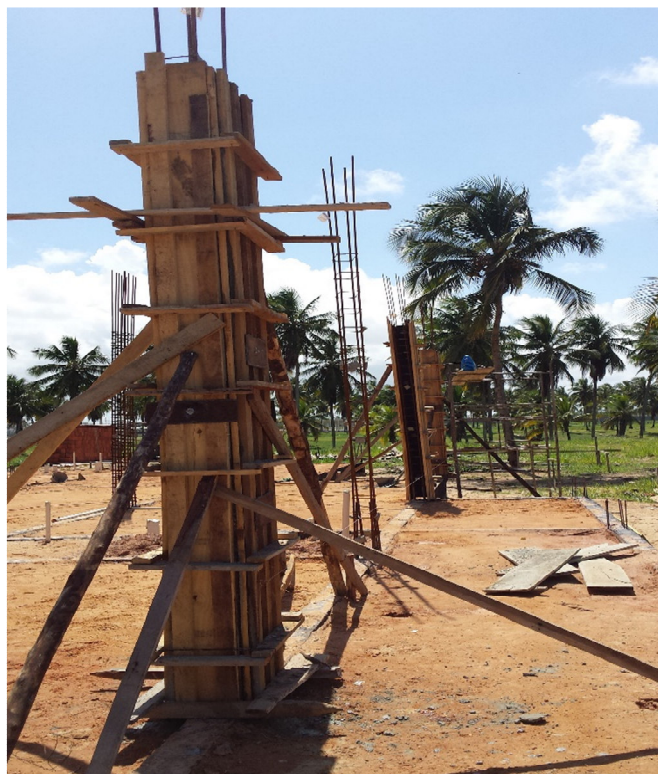
Figura 9 - Armação e posicionamento das fôrmas dos pilares.
