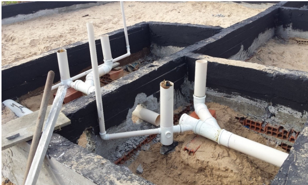
Figura 8 - Passagem das instalações sanitárias.
