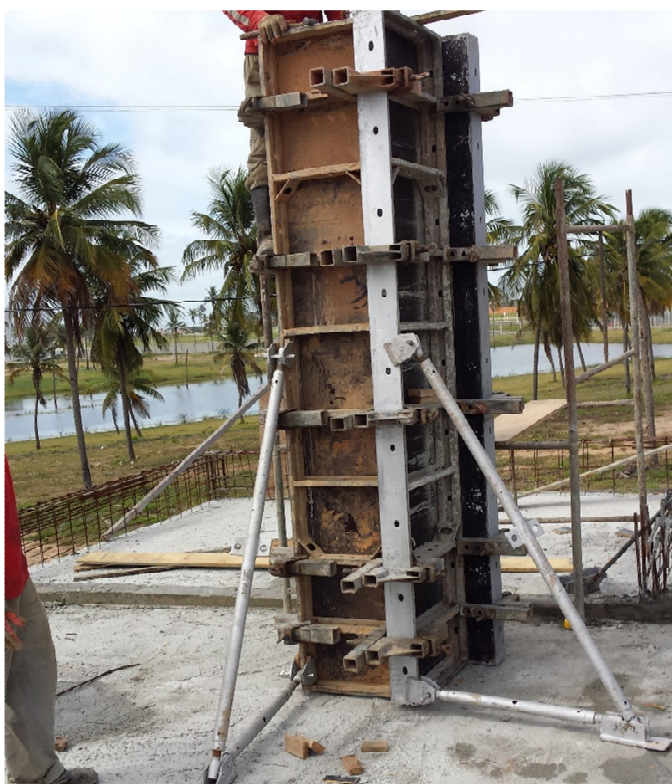
Figura 15 - Posicionamento das fôrmas metálicas dos pilares
