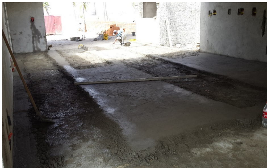
Figura 17 - Execução do contrapiso
