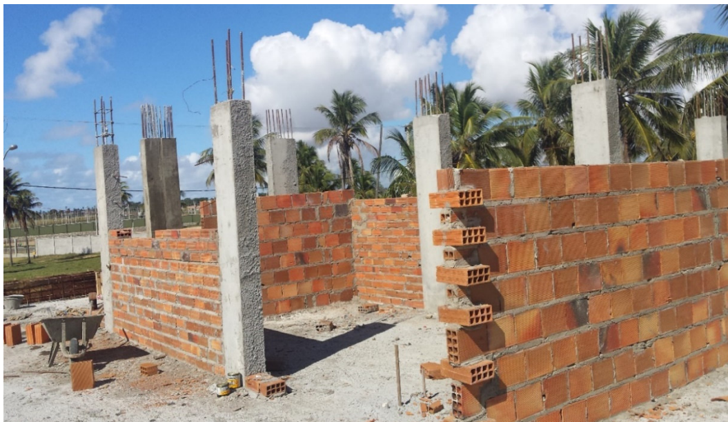
Figura 19 - Levantamento da alvenaria do 2º pavimento
