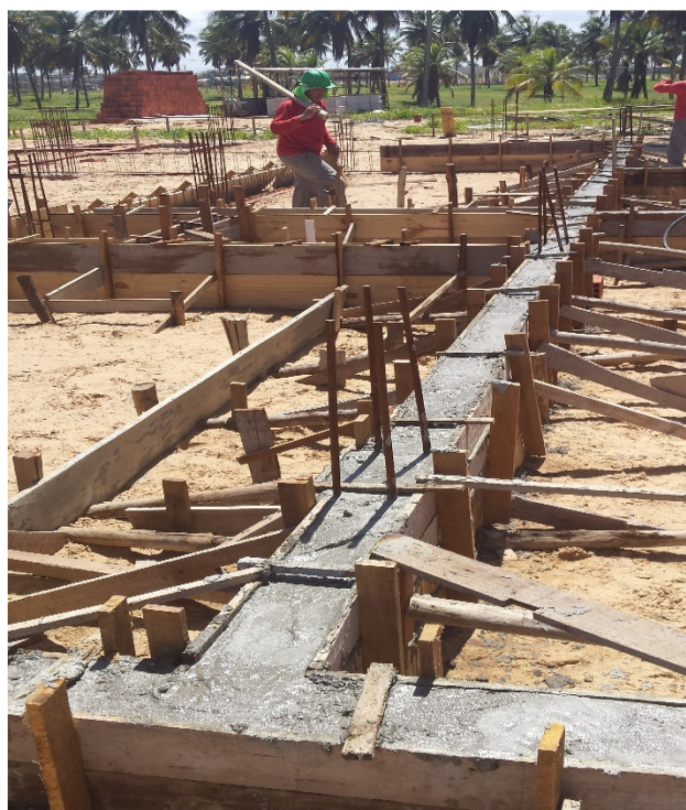
Figura 6 - Escoramento das vigas baldrames.
