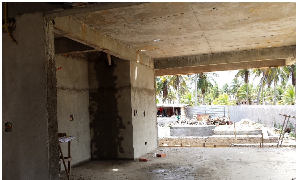
Figura 16 - Reboco do 1º pavimento
