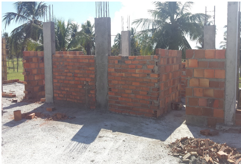
Figura 11 - Elevação da alvenaria
