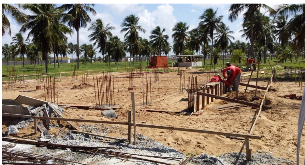
Figura 3 - Colocação das vigas baldrame
