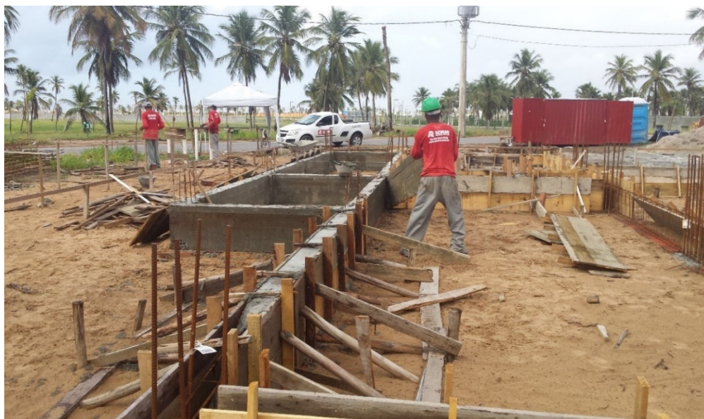
Figura 5 - Recolocação das fôrmas para a concretagem das vigas baldrames.
