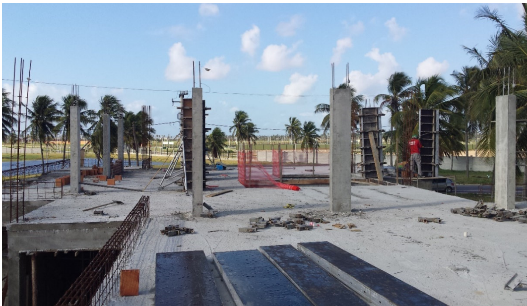
Figura 18 - Desfôrma dos pilares do 2º pavimento
