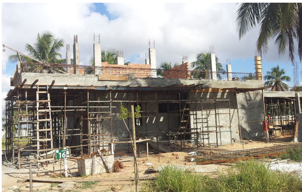
Figura 20 - Vista lateral da obra
