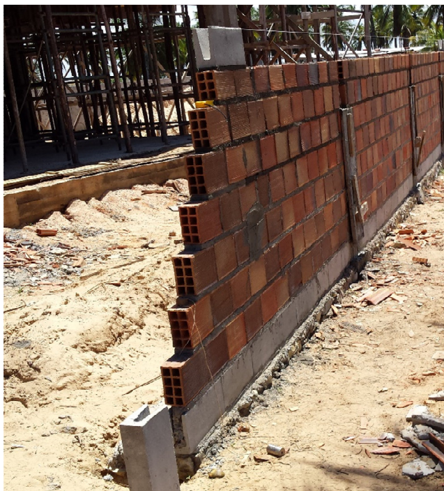
Figura 10 - Elevação da alvenaria do muro lateral.
