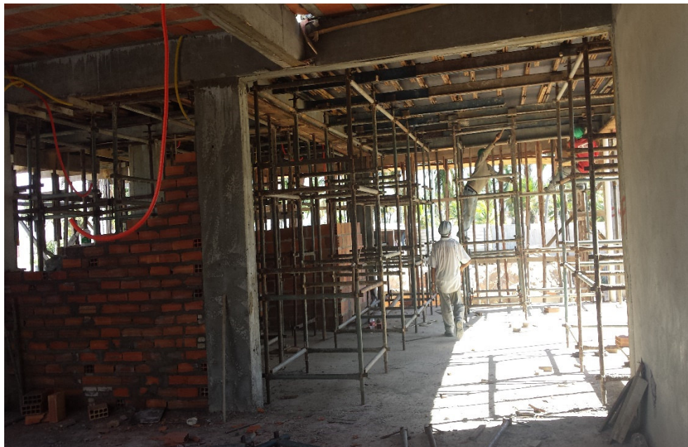
Figura 12 - Elevação da alvenaria e escoramento das lajes
