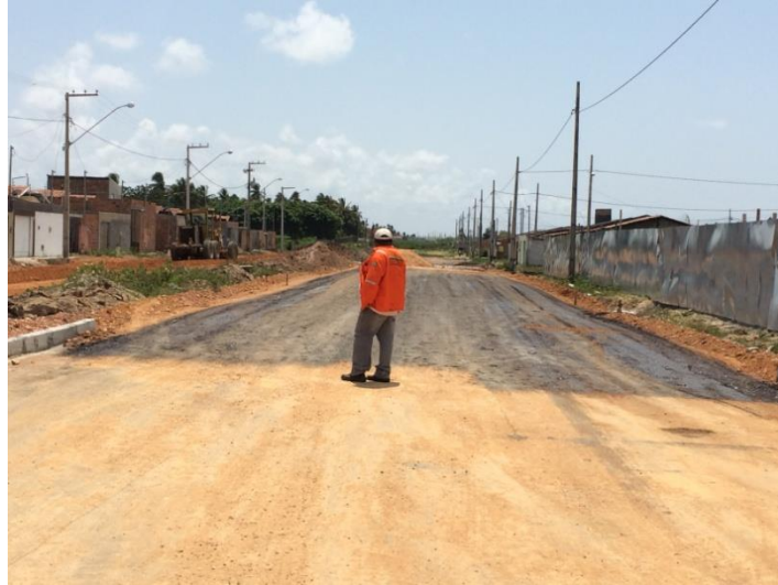
Figura 5 - Pavimentação de rua Fonte: Arquivo digital do autor (2015)
