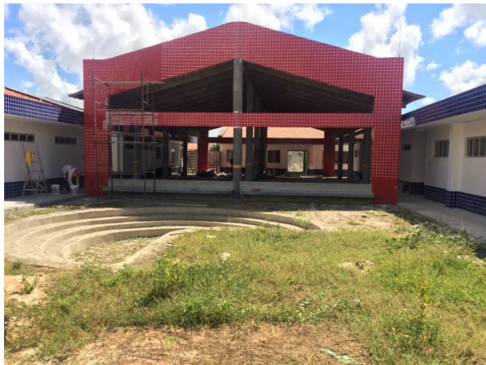
Figura 22 -Execução de rejunte Fonte: Arquivo digital do autor (2015)
