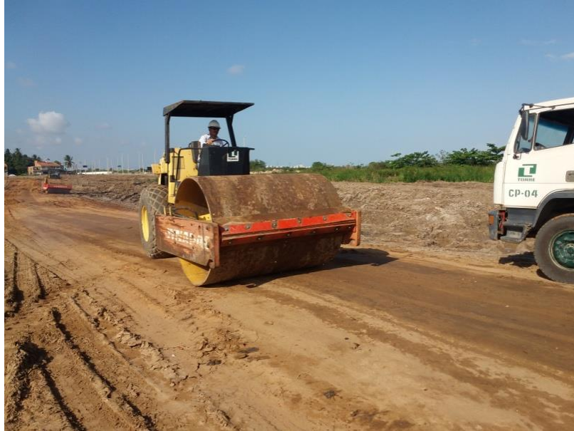
Figura 3 - Rolo Vibratório executando caminho de serviço da Dragagem Fonte: Arquivo digital do autor (2015)
