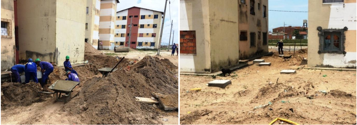
Figuras 7 e 8 - Execução de rede de esgoto Fonte: Arquivo digital do autor (2015)
