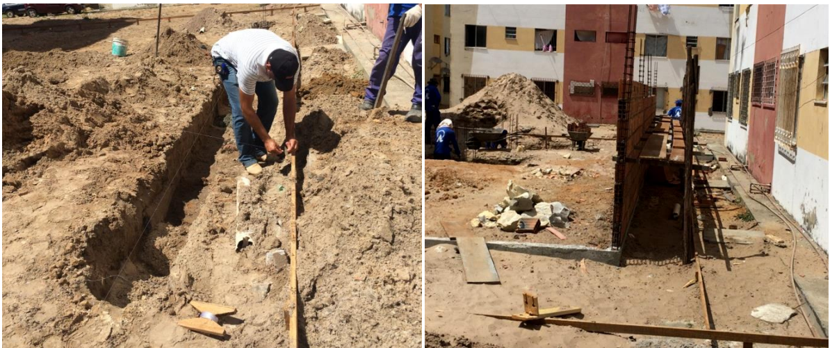
Figura 16 e 17 - Execução de fundação tipo sapata da caixa d'água Fonte: Arquivo digital do autor (2015)
