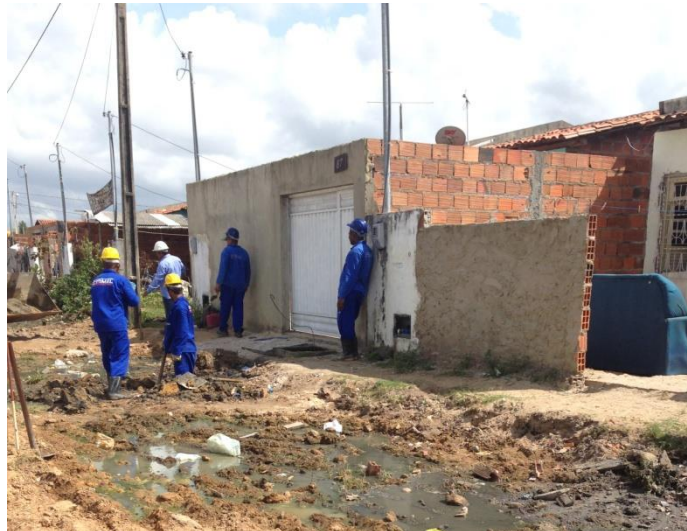
Figura 6 - Execução de rede de esgoto Fonte: Arquivo digital do autor (2015)
