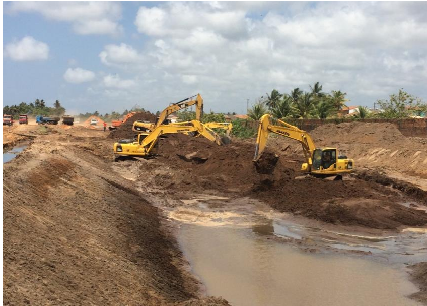
Figura 1 -Dragagem do Canal – Escavadeiras executando serviço Fonte: Arquivo digital do autor (2015)
