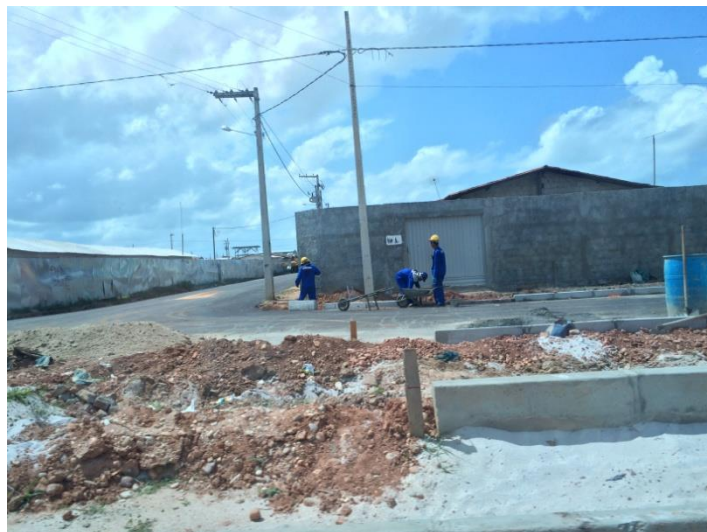
Figura 4 - Execução de meio-fio Fonte: Arquivo digital do autor (2015)
