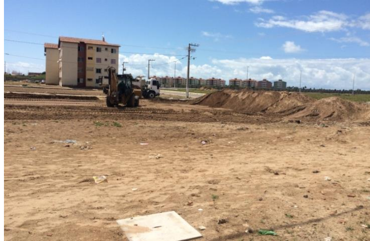
Figura 18 - Nivelamento do pátio referente à Área Externa Fonte: Arquivo digital do autor (2015)
