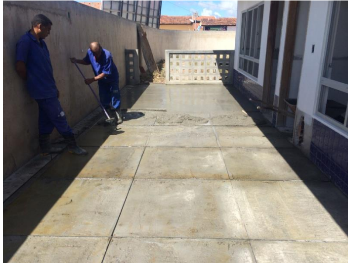
Figura 21 -Execução de piso de alta resistência Fonte: Arquivo digital do autor (2015)
