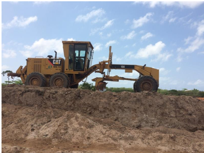
Figura 2 - Moto Niveladora executando serviço na Dragagem Fonte: Arquivo digital do autor (2015)
