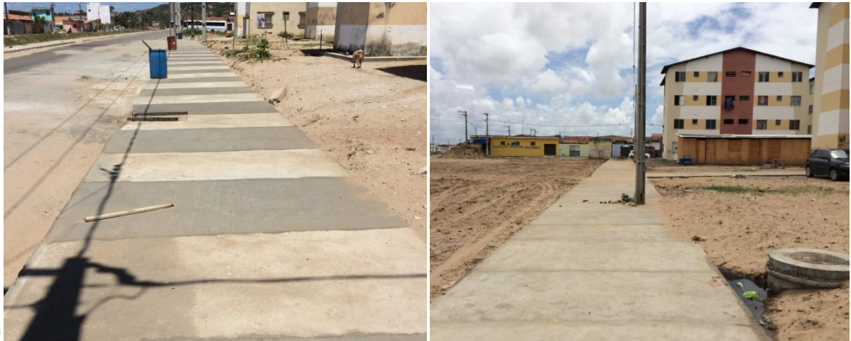
Figura 19 e 20 - Execução de calçadas Fonte: Arquivo digital do autor (2015)
