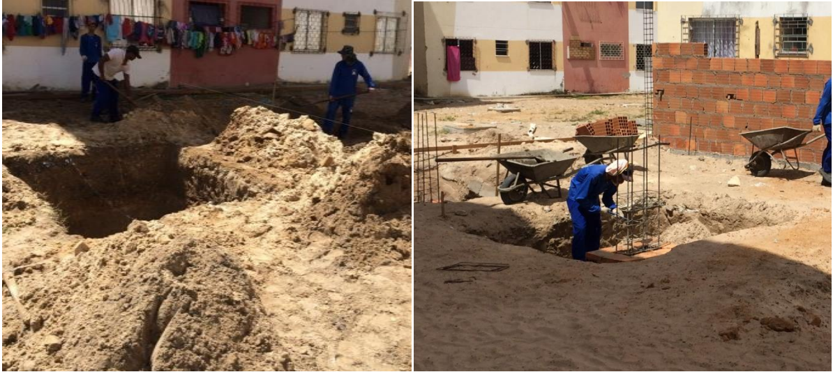
Figura 14 e 15 - Execução de fundação tipo sapata da caixa d'água Fonte: Arquivo digital do autor (2015)
