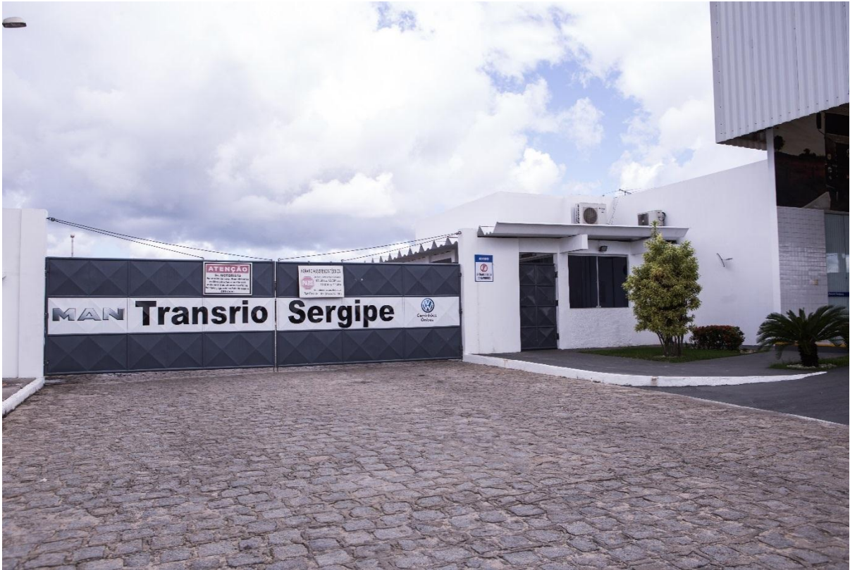
Figura 8 - Portão de acesso à oficina e entrada de ordem de serviços da Transrio Sergipe Fonte: RH, 2016
