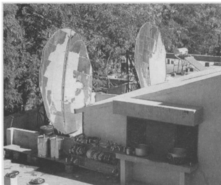
Figura 13: Concentradores Solar tipo Scheffler de 7,5m 2 na cozinha do Instituto de Desenvolvimento Barli (Índia) para Mulheres Rurais, que cozinham para 60-80 pessoas diariamente (PAHISSA, 2014).
