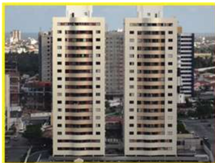
Figura 56– Distanciamento entre as edificações verticais. Aracaju
