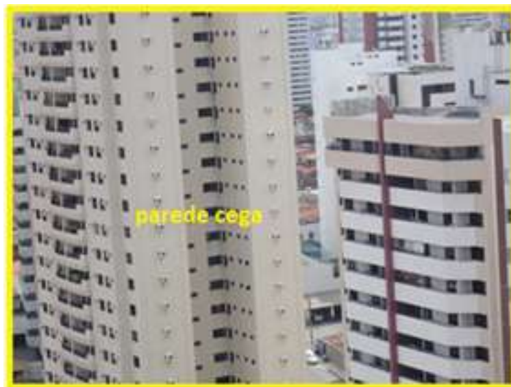
Figura 57– Prédio com “paredes cegas”. Aracaju Fonte: O Autor
